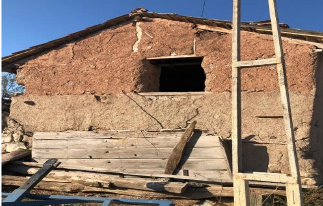
Şekil 17. Tek katlı yapıda 60 cm kalınlığında çift katmanlı duvar
