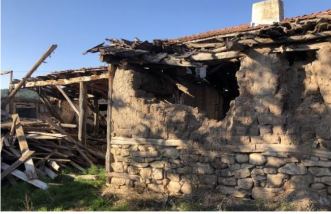
Şekil 16. Eğimli arazide taş temel duvar örgüsünden kerpiç örgüye geçiş
