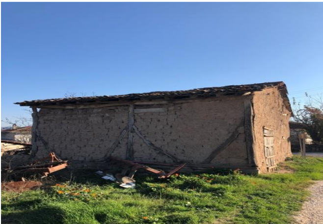
Şekil 15. Ahşap iskelet yapım tekniği ile yapılmış yapı örnekleri
