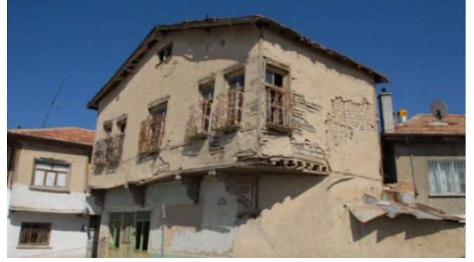
Şekil 4. Karaman ilinde yığma sistem tekniği ile yapılmış bir ev (Değişim Sürüyor, Karaman Büyüyor)
