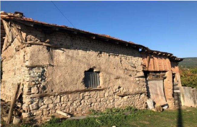
Şekil 7. Subasman seviyesine kadar olan taş temel örgüsünden kerpiç örgüye geçiş
