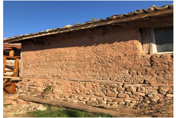
Şekil 11. Subasman seviyesine kadar olan taş temel duvar örgüsünden kerpiç örgüye geçiş
