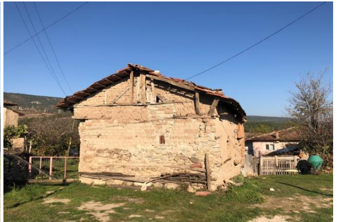
Şekil 15. Ahşap iskelet yapım tekniği ile yapılmış yapı örnekleri
