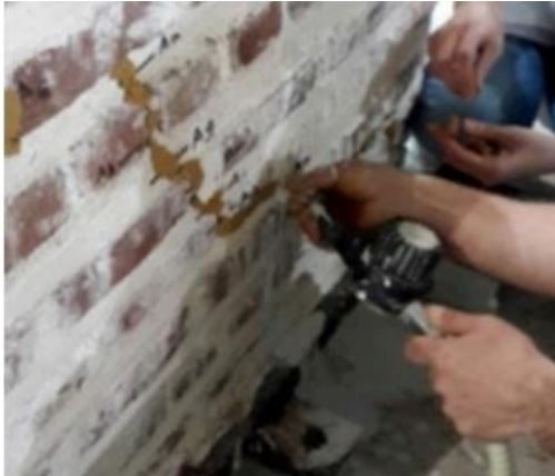
Şekil 18. Çimento enjeksiyonu ile taş duvarların güçlendirilmesi (Akbulut vd. 2018)
