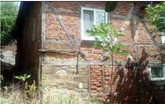
Şekil 8. Eğimli arazide taş temel duvarından tuğla örgüye geçiş
