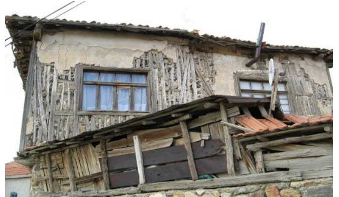
Şekil 5. Yozgat geleneksel mimarisinde ahşap iskelet sistem (Ahşap Yapılar)
