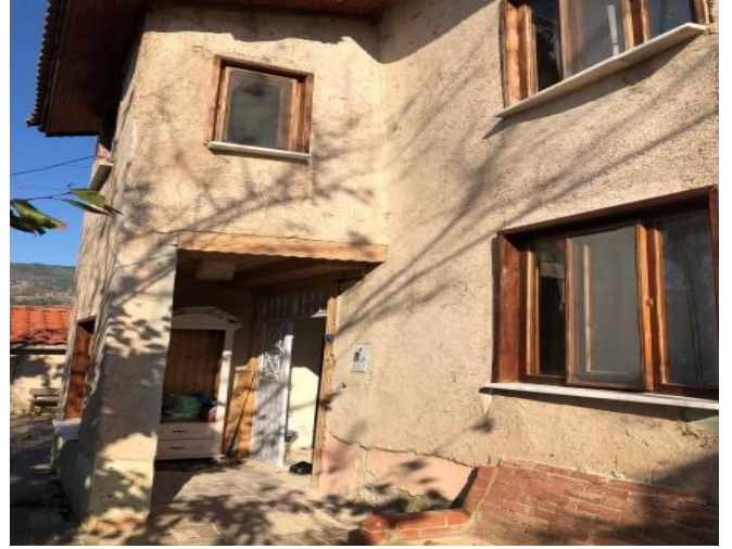
Şekil 14. Kerpiç yığıma yapı örneği
