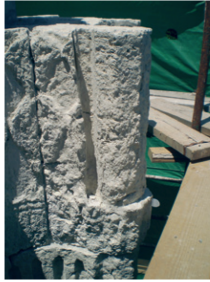
Şekil 33. Taş değişimi öncesindeki görünüm
