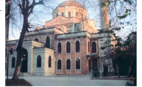
Şekil 5. Kuzeybatı cephesi (Pertevniyal Valide Sultan Camii Rölöve Raporu Fotoğraf Albümü, 2006)
