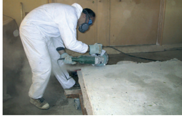
Resim 4. Çimentoların elmas uçlu diskler ile kesilmesi
