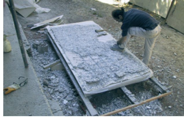
Resim 5. Çimentoların mekanik olarak temizlenmesi
