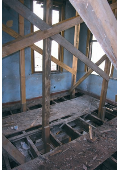
Şekil 7. Hasarlı döşeme levhaları sökülerek sürekli hale getirilen askı iskelesi (Ekim 2008)
