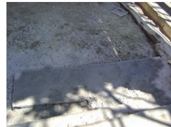
Şekil 23. Kismen korunmuş özgün mermer döşeme (ZK09 mekanı; 2008)
