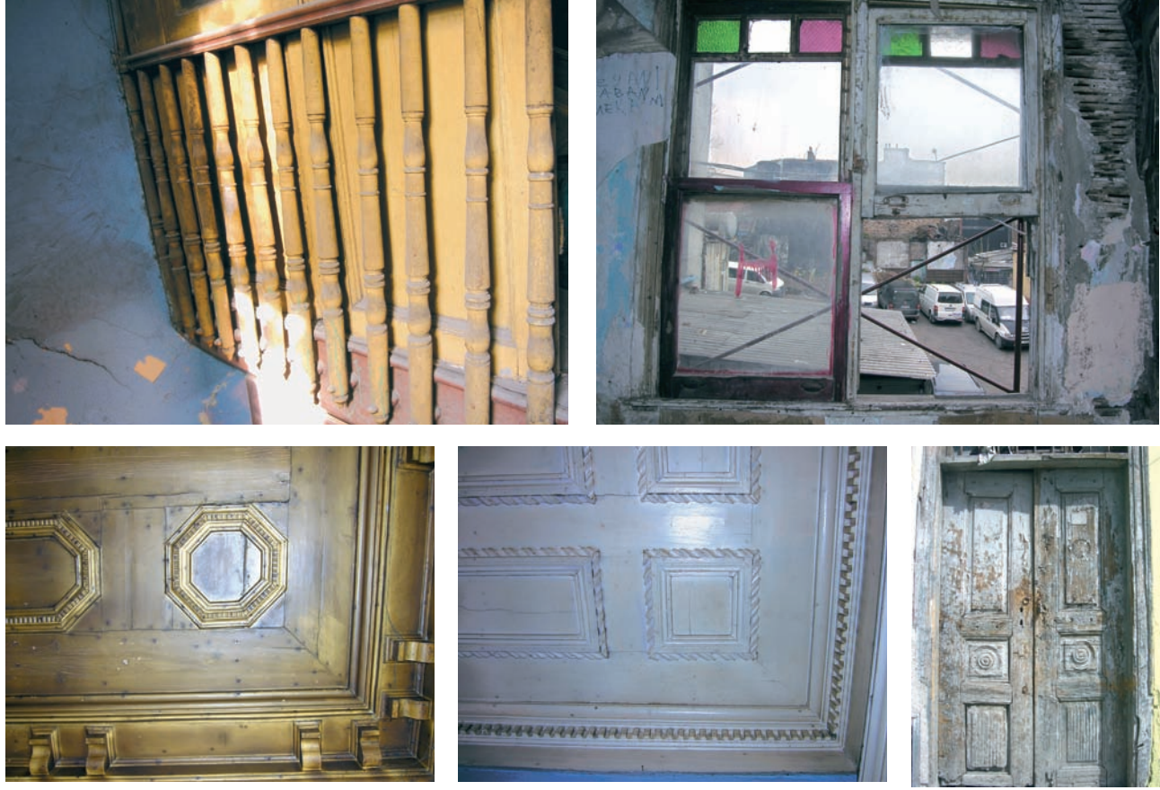
Şekil 2. Yapının özgünlüğünü koruyarak bugüne ulaşan bazı eleman ve detayları (Nisan 2008)
