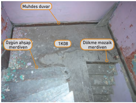
Şekil 22. Kaldırılan muhdes merdiven ve duvarlar (Kasım 2008)
