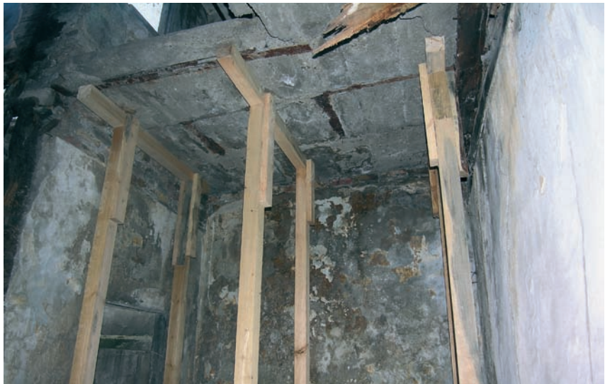
Şekil 5. Muhdes beton döşemenin desteklenmesi (Temmuz 2008)
