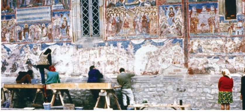
Romanya çalışmaları çerçevesinde Moldavya'nın Rusya sınırı yakınlarında bulunan bir kilisenin dış duvar fresklerinde konservasyon uygulaması (1973)
