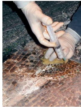
Malta 6001 enjeksiyonu ile tessera ve yatak harcı sağlamlaştırma çalışmaları
