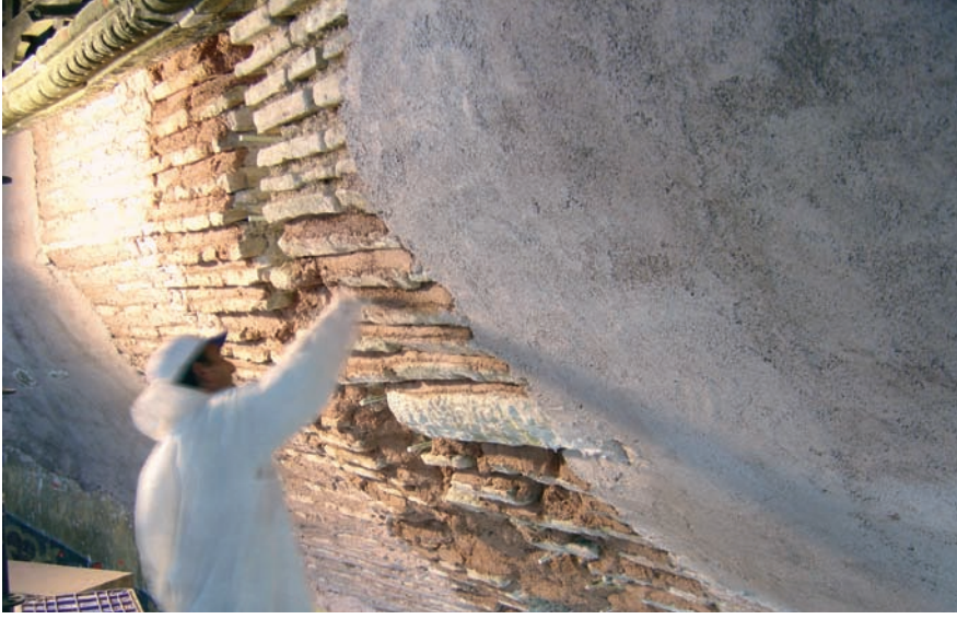
Güneybatı Serafimi'nde sıva uygulaması
