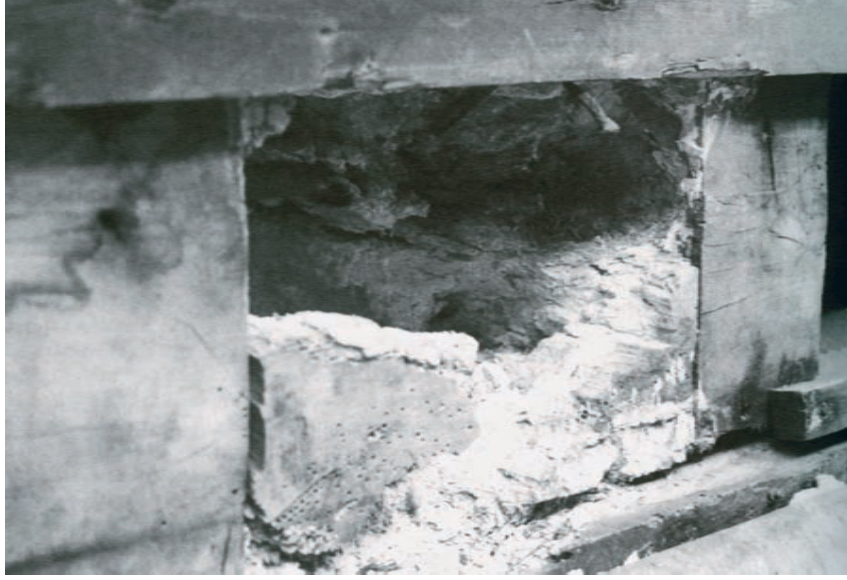
Resim 1. Beyaz çürüklük, normalde yumuşak odundan ziyade sert odunda daha fazla görülür. "White rots are more common in hardwoods than in softwoods" (Ridout, 2004)
