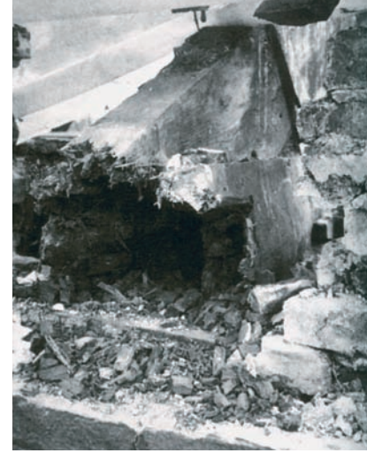
Resim 2. Kahverengi çürüklük, sert odundan ziyade yumuşak odunda daha fazla görülür. "Brown rots are more common in softwoods than in hardwoods" (Ridout, 2004)
