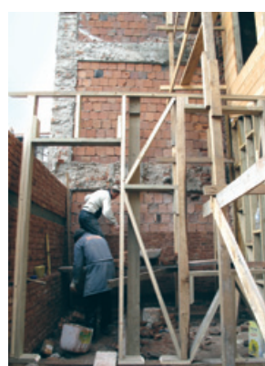
Şekil 38. Yangın duvarının ve bahçedeki müştemilatın yapımı
