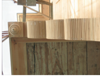
Şekil 42. Çıkma altındaki eliböğünde çıtalarının ve döşeme kaplamalarının montajı
