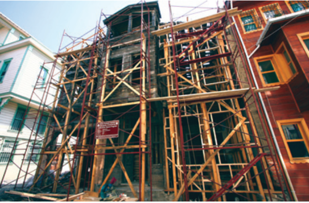
Sekil 31. Yapı askıya alındıktan sonra dikmelerin takviyesi ve değişimi
