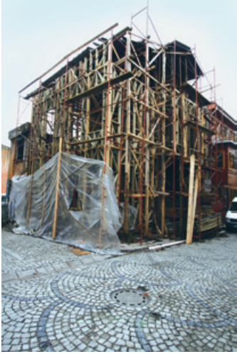
Şekil 34. Yapının taşıyıcı sistem tamamlandıktan sonraki durumu
