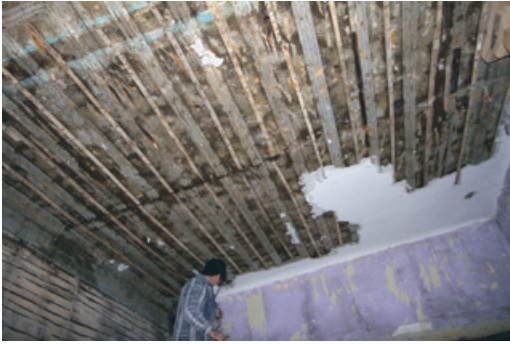
Şekil 27. Zemin katta dükkâna dönüştürülen hacimde siva rasması ve ahşap tavanın ortaya çıkarılması
