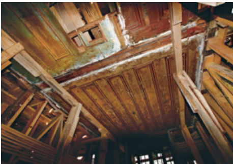
Şekil 37. Sağlam durumdaki özgün ahşap tavanların korunması ve eksik kısımların tamamlanması
