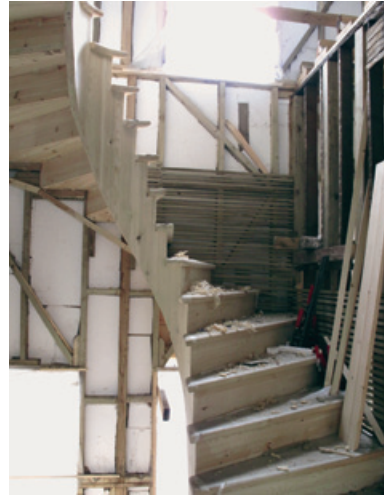
Şekil 42. Çıkma altındaki eliböğünde çıtalarının ve döşeme kaplamalarının montajı
