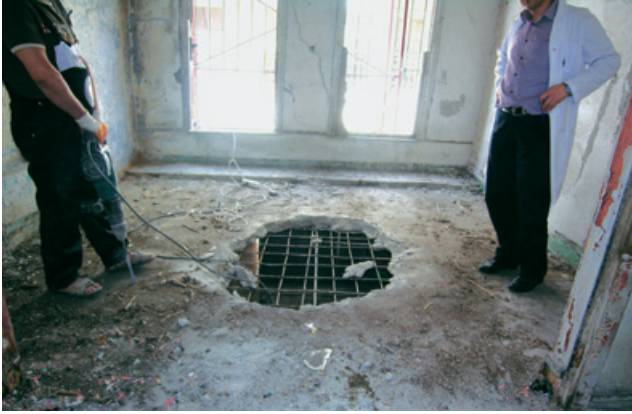
Şekil 26. Zemin kattaki betonarme döşemenin kaldırılması ve çimentolu sıvaların rasması
