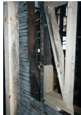
Sekil 32. Özgün sağlam ahşap elemanlarla yeni elemanların bir arada kullanılması
