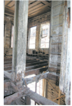
Şekil 28. 1.kat duvarlarındaki çimentolu siva rasması sonrasında döşeme kaplamalarının sökülmesi
