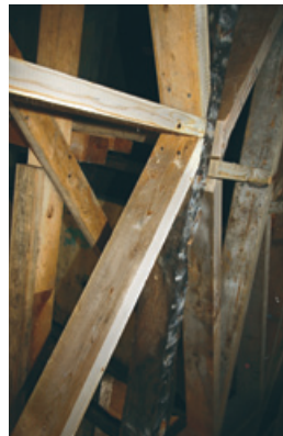
Sekil 31. Yapı askıya alındıktan sonra dikmelerin takviyesi ve değişimi
