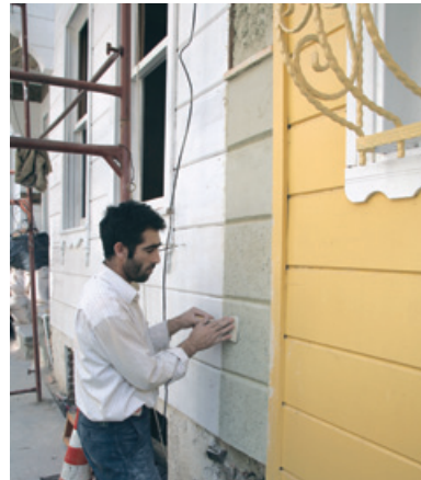
Şekil 44. Duvar sıvası ve yangın duvarı üzerinde suni taş sıva uygulaması
