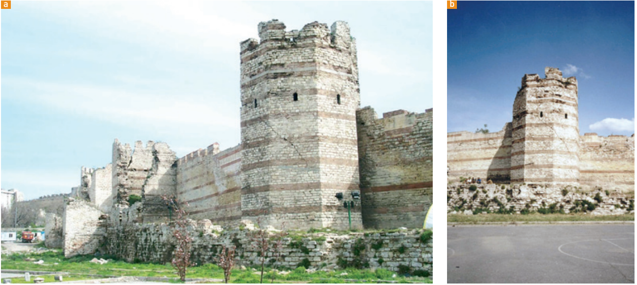
Şekil 1. İstanbul, Yedikule karasurlarından genel görünüş, a) T4 kulesi ve karasurlarının görüntüsü 4, b) T4 kulesinden bir detay görüntü.
