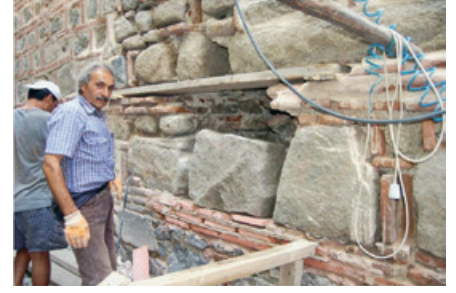
Resim 15. Beden duvarlarındaki çatlakların dikiş yöntemi ile onarılması
