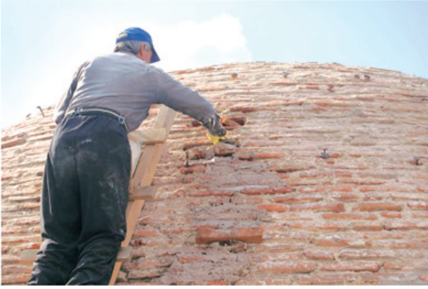
Resim 10. Çatlakların dikiş yöntemi ile tamir edilmesi
