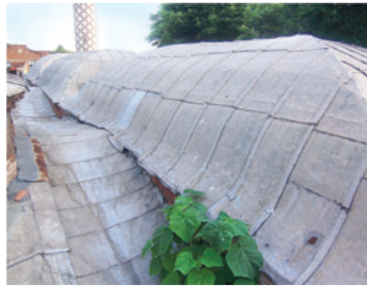
Resim 6. Restorasyon öncesi çatının görünümü
