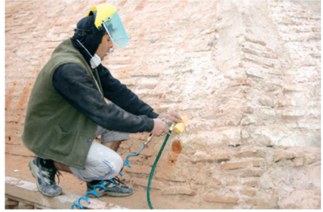
Resim 11. Kubbe ve tonozlarda yapılan enjeksiyon uygulaması
