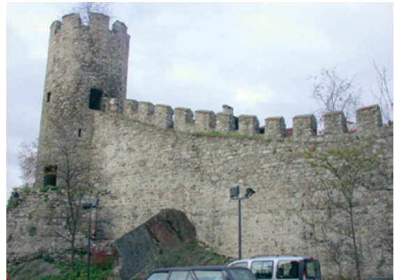
Şekil 2. Kara tarafındaki burç ve duvarlar
