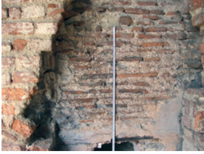
Şekil 19-20-21. MB.46 no.lu örneğin alındığı kısım (tuğla boyutları 32x16x 3cm, derz aralıkları 6cm (sol), GY.12 no.lu örneğin alındığı kısım (orta), SAY.3 no.lu örneğin alındığı kısım (tuğla boyutları 24.x12x4cm, derz aralıkları 4 cm; sağ)
