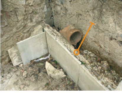
Şekil 10-11. Hamam olduğu düşünülen yapıda mermer levhaların sabitlenmesi için kullanılmış sıva tabakasından alınan ÇUY.15 no.lu örnek (sol), hidrolik özellik gösteren SAY.2 no.lu örneğin kesit dokusu (sağ)
