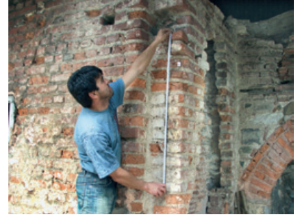
Şekil 19-20-21. MB.46 no.lu örneğin alındığı kısım (tuğla boyutları 32x16x 3cm, derz aralıkları 6cm (sol), GY.12 no.lu örneğin alındığı kısım (orta), SAY.3 no.lu örneğin alındığı kısım (tuğla boyutları 24.x12x4cm, derz aralıkları 4 cm; sağ)
