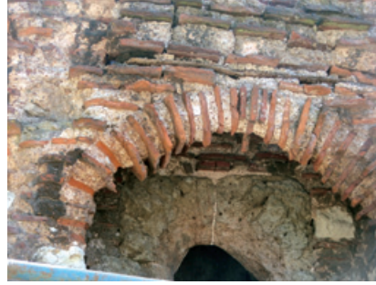
Şekil 19-20-21. MB.46 no.lu örneğin alındığı kısım (tuğla boyutları 32x16x 3cm, derz aralıkları 6cm (sol), GY.12 no.lu örneğin alındığı kısım (orta), SAY.3 no.lu örneğin alındığı kısım (tuğla boyutları 24.x12x4cm, derz aralıkları 4 cm; sağ)
