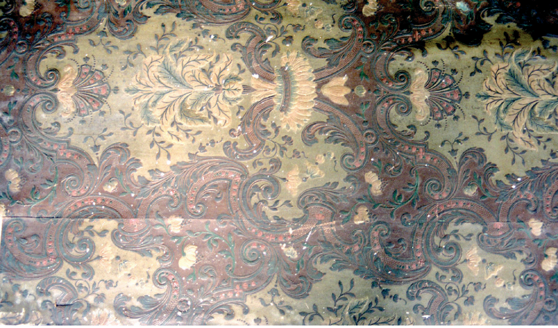
Resim 12. Duvar kağıdı yüzeyinde görülen boya damlacıkları
