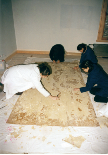
Resim 9. Korunmasına karar verilmiş olan son dönem duvar kağıtları için problem olmaya devam eden kağıt kırıntılarının ve yapıştırıcı kalıntılarının mekanik yöntemle temizlenmesi
