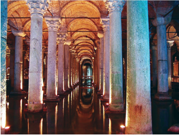
Şekil 15. Yerebatan Sarnıcı'nda taşıyıcı sütun olarak kullanılan Kestanbol granitleri
