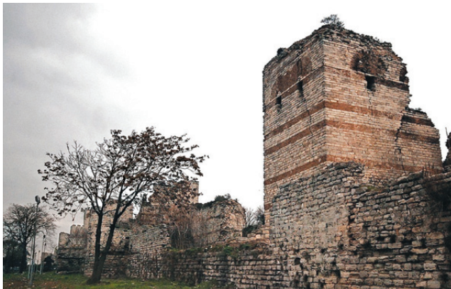
Şekil 6. Roma Dönemi’nde inşa edilen Theodosius Surları’nın yapımında kullanılan Bakırköy küfeki taşları
