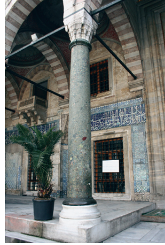
Şekil 27. Emi-nönü Yeni Cami'nin avlusunda taşıyıcı sütun olarak kullanılan Mısır pudingi
