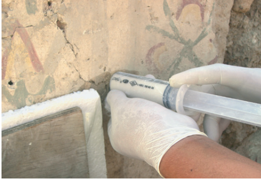
Resim 18. Sıva-duvar arası sağlamlaştırma
