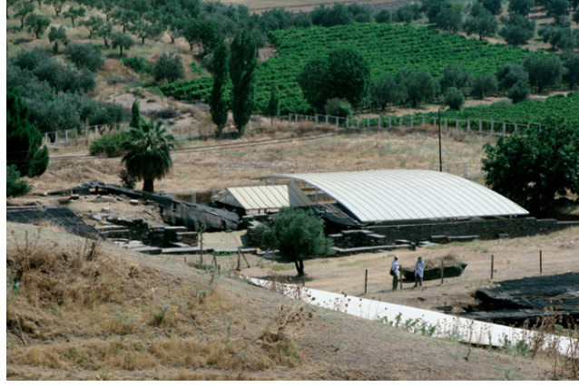
Resim 5. Korumacı çatı ile koruma altına alınan yapı kalıntıları (Sardis Kazısı)
