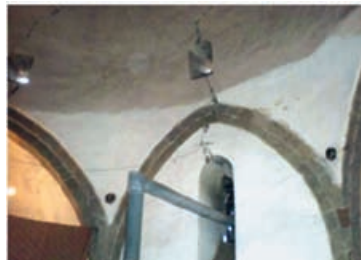
Şekil 6. Kubbenin alt kısmında meydana gelen açılmalar
