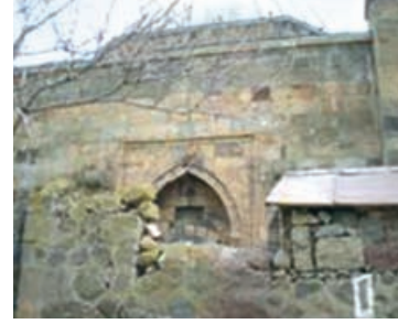
Şekil 3. Cami cephelerinden görünüm
