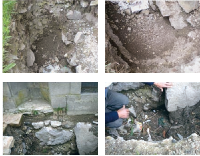
Şekil 2. Taşıyıcı yığma duvar tabanında açılan araştırma çukurları
