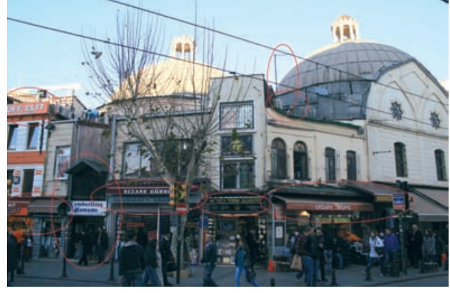
Şekil 58. Çemberlitaş Hamamı'nda anten, klima, tente ve giriş saçağı eklentileri (İ.SAĞDIC; 2011)
