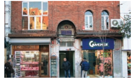
Şekil 51. Mimar Hayrettin Camisi'nin zemin katındaki dükkânlarda bulunan tabela, klima, vs. eklentiler (İ.SAĞDIÇ; 2011)
