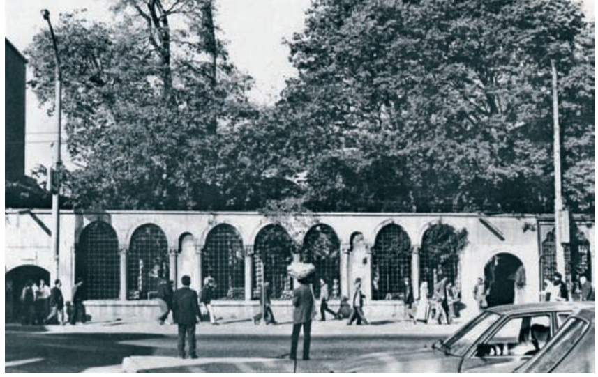
Şekil 35. Çorlulu Ali Paşa Külliyesi, Divanyolu cephesi (Eminönü Camileri, 1987; s.56)
