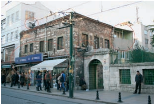
Şekil 52. Atık Ali Külliyesi'ne ait Muvakkithane - Sıbyan Mektebi, tabela, tente, klima, vb. eklentiler (İ.SAĞDIÇ; 2011)
