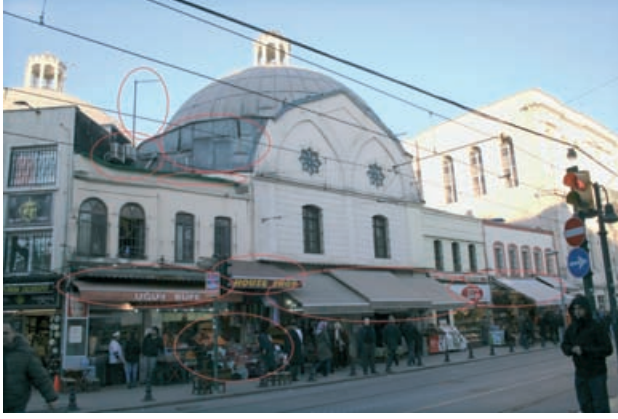
Şekil 57. Çemberlitaş Hamamı'nda anten, klima, tente ve giriş saçağı eklentileri (İ.SAĞDIC; 2011)
