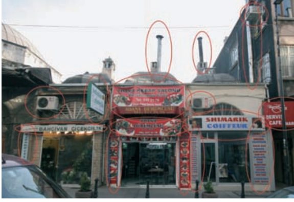
Şekil 61. Köprülü Mehmet Paşa Külliyesine ait dükkanlardaki tabela, klima ve tahliye bacası eklentileri (İ.SAĞDIC; 2011)
