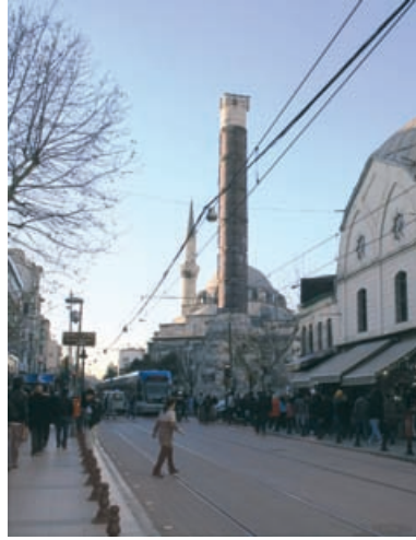
Şekil 13. Çemberlitaş hamamının Barborini tarafından yapılan günümüz cephesi (İ.SAĞDIÇ; 2011)
