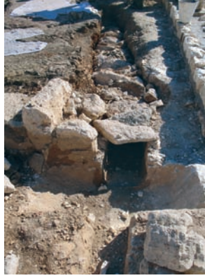
Resim 18. Ortaya çıkan kanallar ve restorasyon çalışmaları
