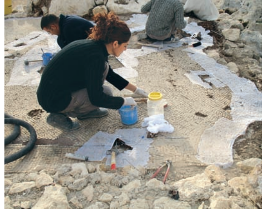
Resim 19. Facing ve enjeksiyon çalışmaları
