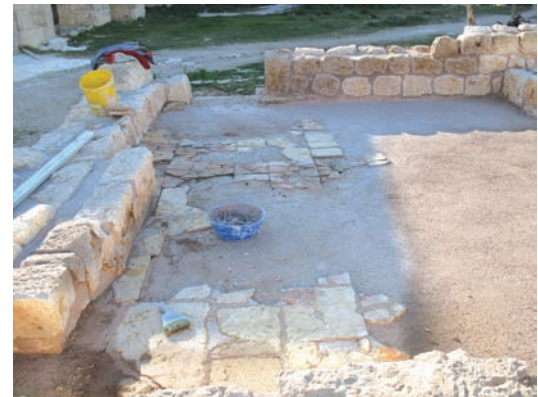
Resim 8. Döşemelerin restorasyon sonrası durumu
