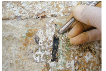
Mekanik temizleme uygulaması
