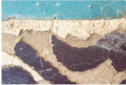
Şekil 21. Mozaik çini yüzeyi ile alçı sıvanın görünümü
