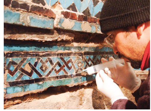
Şekil 5. Eşrefoğlu Türbesi restorasyon esnasında
