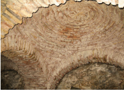
Şekil 23. Seyh Murat Mescidi Yakınındaki Sarnıcı'ta yelken, Gülhane Parkı Sarnıcı'nda kubbe ve Binbirdirek (Philoksenos?) Sarnıcı'nda çapraz tonoz uygulamaları
