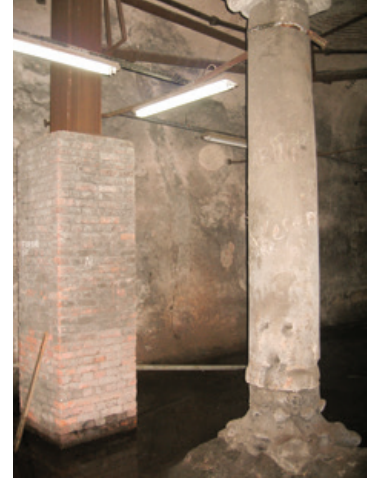
Şekil 12. İpek Bodrumu (Artamonoff, 1936) ve İstanbul Lisesi Altındaki Sarnıç'ta kaide olarak sütun başlığı kullanımı.
