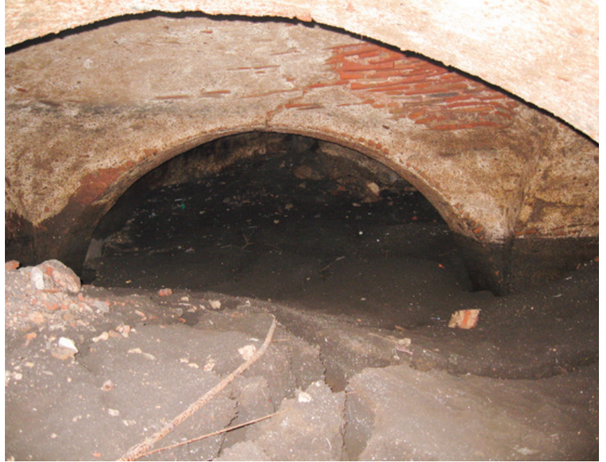
Şekil 3. Beyazıt I no.lu Sarnıç ile Vefa Meydanı Sarnıcı içerisindeki dolgu seviyelerinin görünümü.
