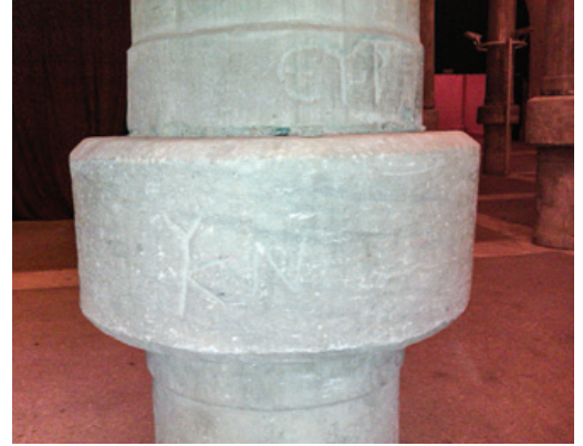
Şekil 13. Binbirdirek (Philoksenos?) Sarnıcı'nda iki parçalı sütun uygulaması.
