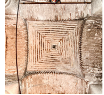
Şekil 23. Seyh Murat Mescidi Yakınındaki Sarnıcı'ta yelken, Gülhane Parkı Sarnıcı'nda kubbe ve Binbirdirek (Philoksenos?) Sarnıcı'nda çapraz tonoz uygulamaları
