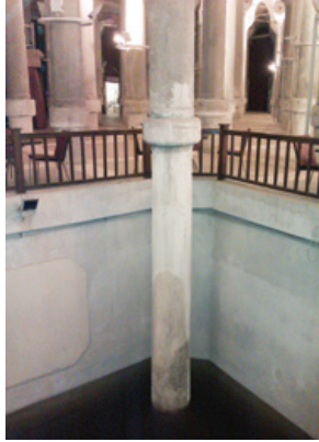
Şekil 13. Binbirdirek (Philoksenos?) Sarnıcı'nda iki parçalı sütun uygulaması.
