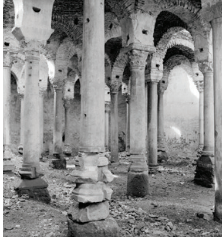
Şekil 12. İpek Bodrumu (Artamonoff, 1936) ve İstanbul Lisesi Altındaki Sarnıç'ta kaide olarak sütun başlığı kullanımı.
