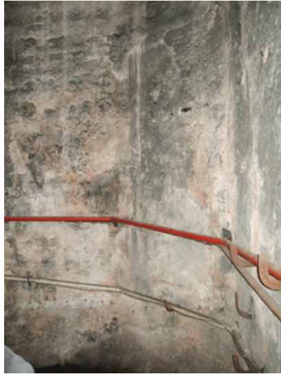
Şekil 5. İstanbul Lisesi Altındaki Sarnıç ve Besler Han Sarnıcı'nda köşe pahlama uygulamaları (Koruma Kurulu Arşivi).
