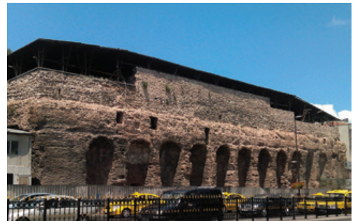
Şekil 11. Sofular Caddesi'ndeki Sarnıç (Müller-Wiener, 1977) ve Zeyrek (Pantokrator) Sarnıcı'ndaki payandalar.
