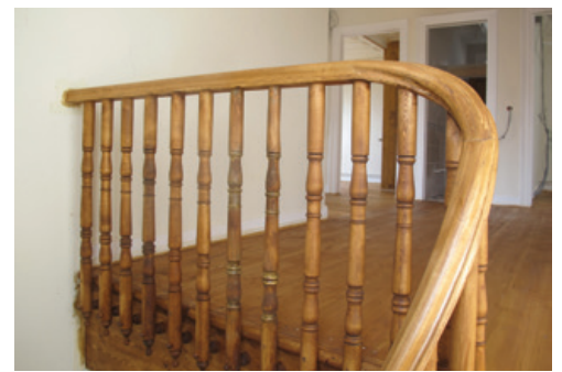
Şekil 37. Ahşap kúpeste ve korkuluklar (önce-sonra).
