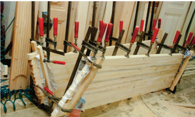
Şekil 33. Basamakların yapımı ve montajı.
