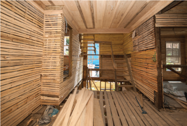
Şekil 5. Yarma bağıdadî duvarların sıvadan önceki görünümü.
