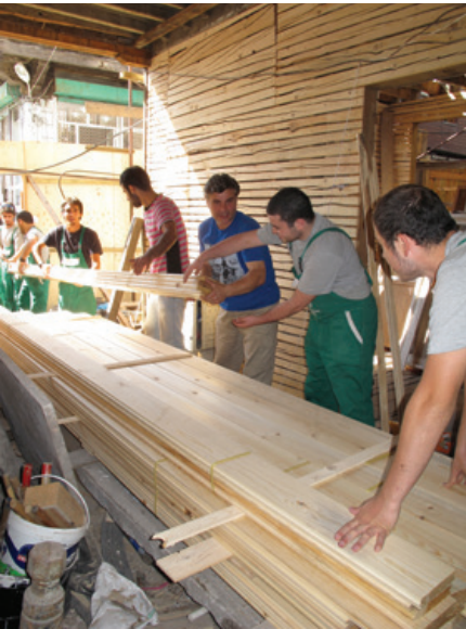
Şekil 22. Döşeme levhalarının şantiyede istiflenmesi. Şekil 23. Döşeme planı.
