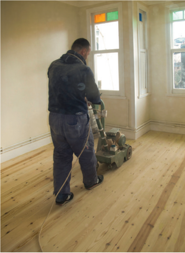
Şekil 49. Sistire işlemi.
