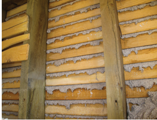
Şekil 44. Bağdadî duvarda sıvanın ahşap çitalara tutunması.
