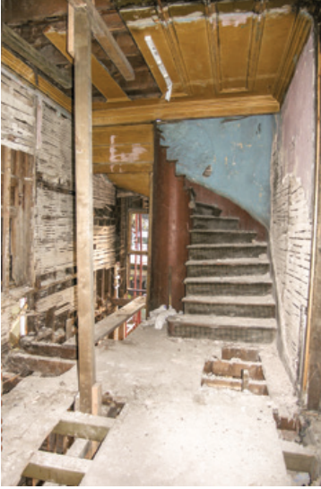
Şekil 28. Özgül ahşap merdiven.
