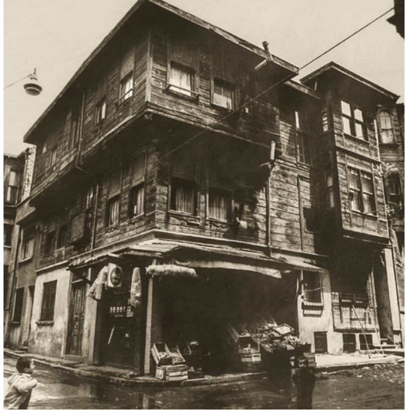
Şekil 1. Parselde yer alan iki ahşap yapı (Kültür Varlıklarını Koruma Bölge Kurulu Arşivi).
