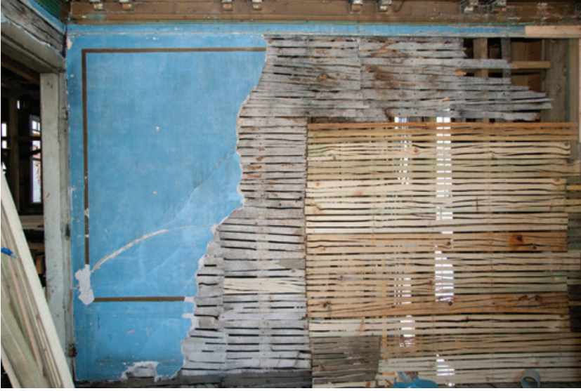
Şekil 3. Bütünleme yapılan yarma bağıdadî duvarlar.
