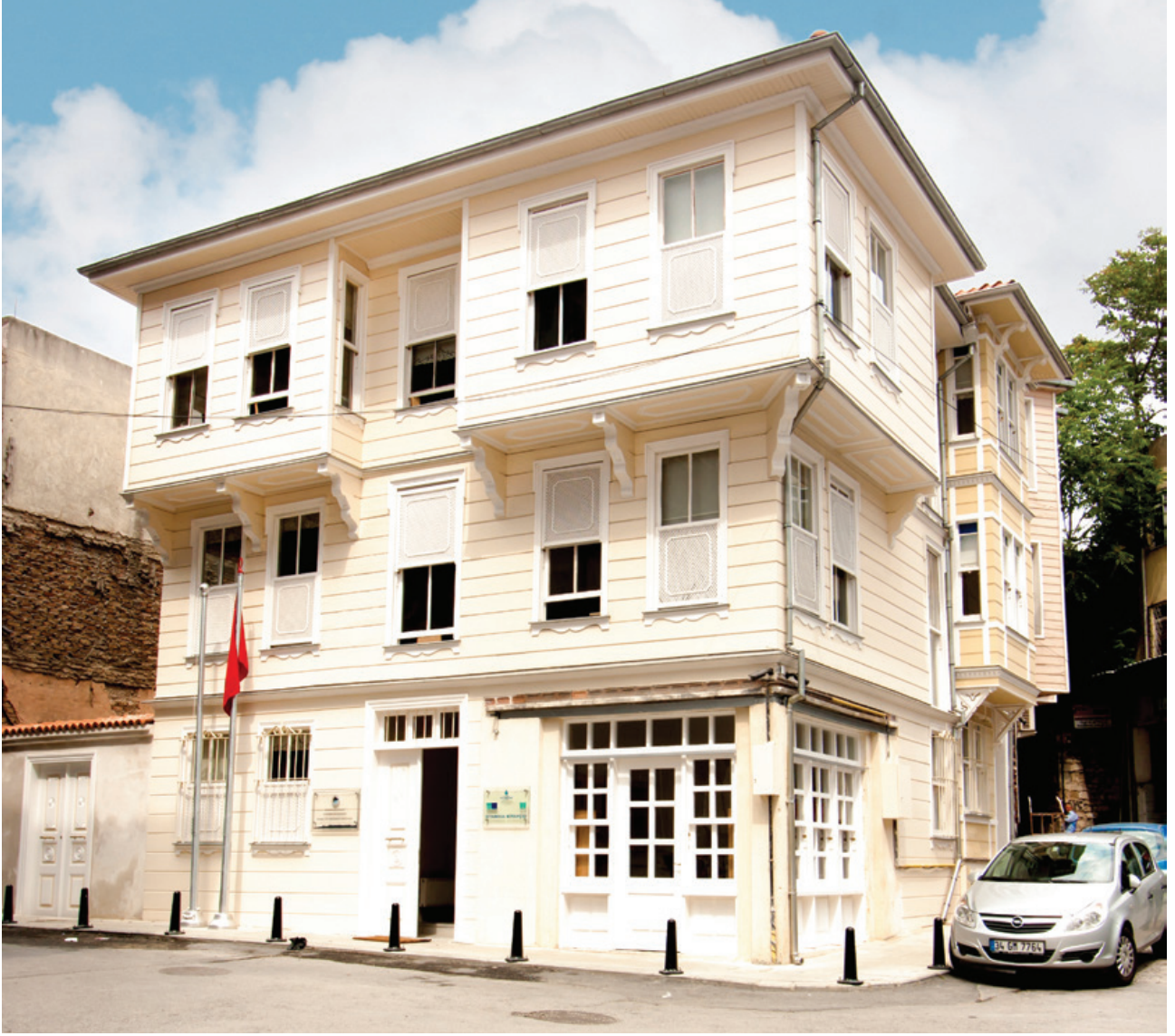
Şekil 53. Yapının onarım sonrası görünümü.
