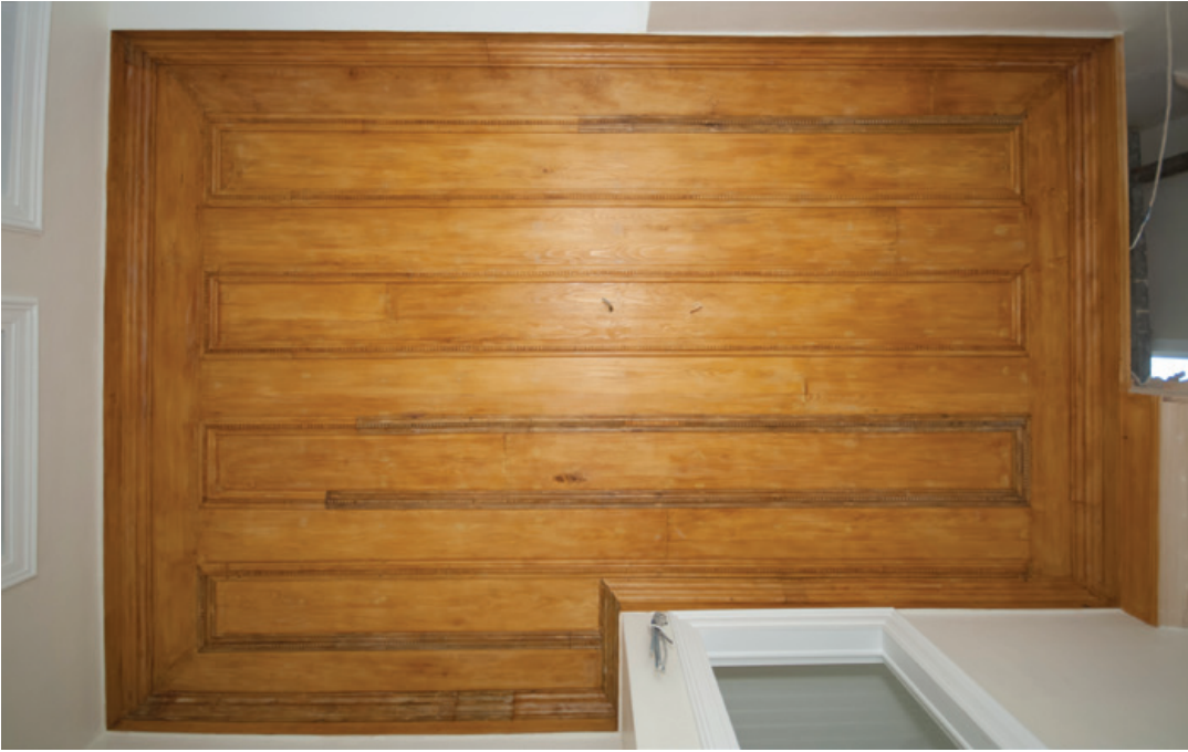
Şekil 46. 1K01/A tavanında gomalak cilâ uygulaması
