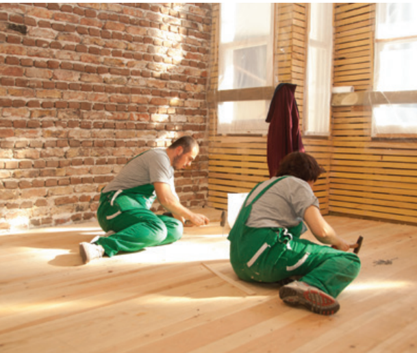
Şekil 24. Ahşap döşeme levhalarının çakılması
