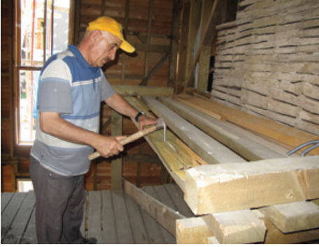
Şekil 4. Yarma bağıdadî duvar yapımı-çitaların yarılması ve çakılması.
