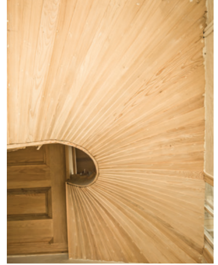
Şekil 35. Merdiven altı kaplaması.
