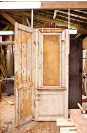
Şekil 41. Özgün ahşap yüklüğün atölyede onarımı.
