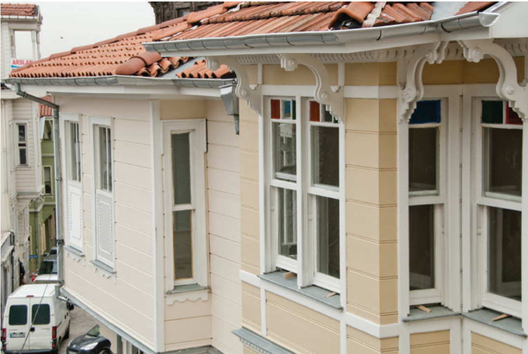
Şekil 47. Dış cephede boya uygulaması.
