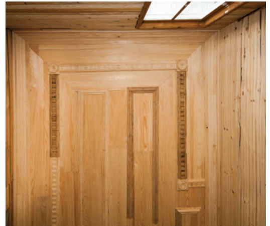
Şekil 16. 2K01/A tavanında bütünleme uygulaması.
