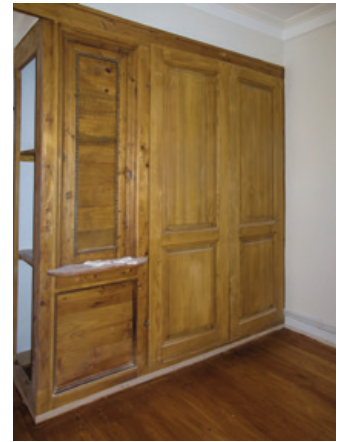
Şekil 43. Ahşap koruyucu uygulamadan sonra yüklüğün görünümü.
