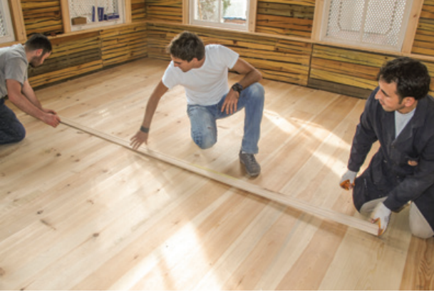
Şekil 25. Ahşap döşeme levhalarının çakılması.
