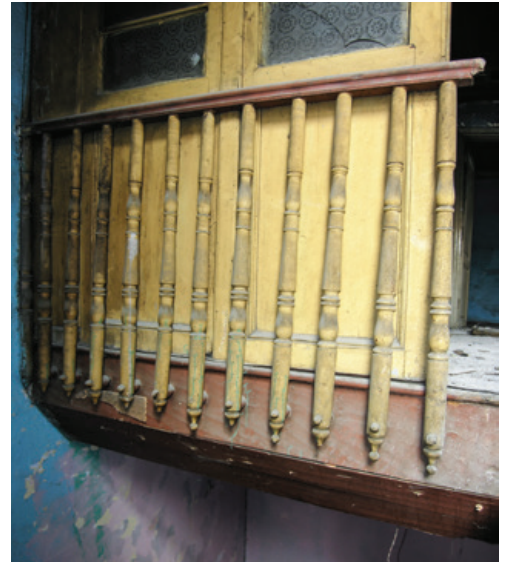
Şekil 35. Merdiven altı kaplaması.
