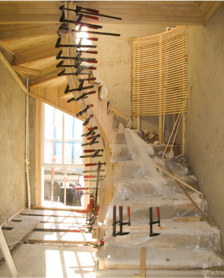
Şekil 36. Kúpestenin yapımı.
