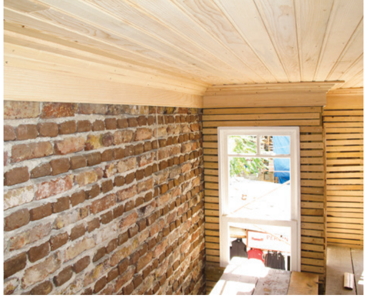
Şekil 20. Dönem eki yapıda tavan uygulaması.
