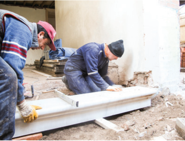
Şekil 26. ZK01'de mermer döşeme yapımı.
