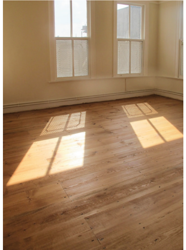
Şekil 50. Ahşap döşemenin son durumu.
