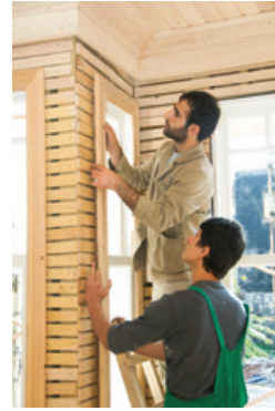
Şekil 40. Pervazların montajı.
