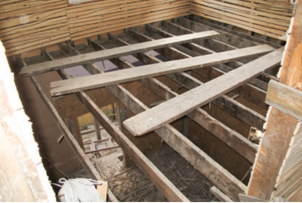
Şekil 21. Yerinde korunan özgün döşeme kirişleri.
