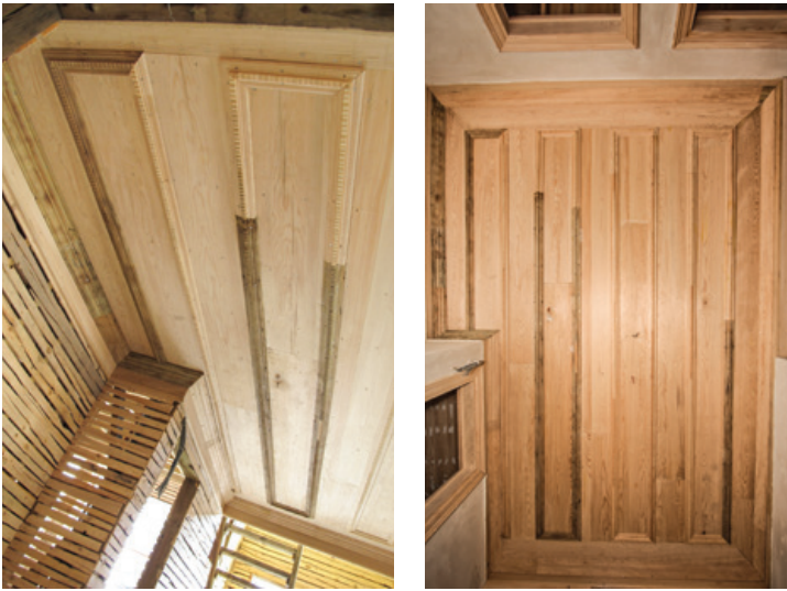
Şekil 15. 1K01/A tavanında bütünleme uygulaması.
