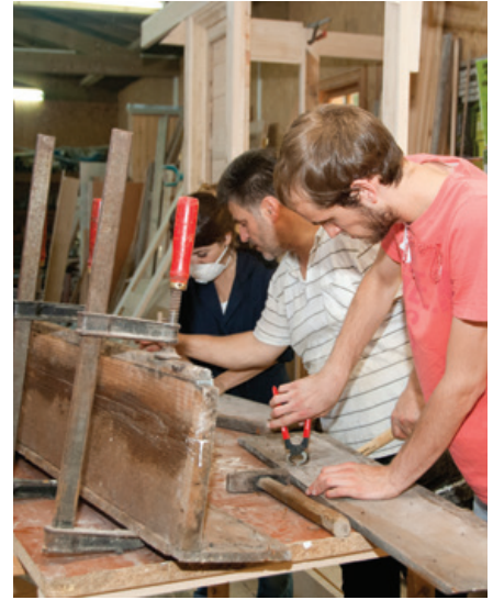
Şekil 30. Özgül merdiven elemanlarının onarımı.
