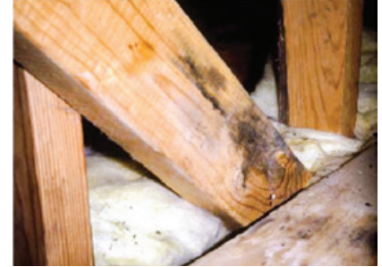
Şekil 2. Bir çatı katı ahşap girişinde küf mantarlarının oluşturduğu renklenme (Forest Products Laboratory TechLine, 1999)
