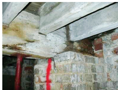
Şekil 4. Bir yapının, biyolojik bozunma riski yüksek olan bodrum katında duvarla temas eden ahşap elemanlar (www.trada.co.uk).
