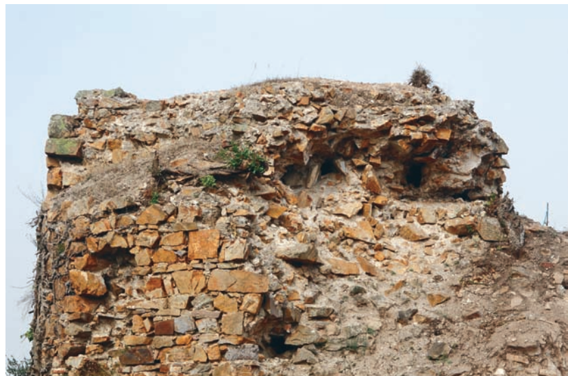
Şekil 4. Aydos Kalesi duvarlarında kullanılan işlenmiş kuvarsarenit blokları
