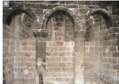
Şekil 8. Suriçi'ni çevreleyen duvarların üzerinde yer alan iki burcun sütunlarını gösteren fotoğraflar: (a) Yedi Kardeş burcu, (b) Keçi burcu. Sütunlar yekpare olup metal halkalar, kırılmayı önlemek için kullanılmıştır. (Fotoğraf: Neslihan Dalkılıç)
