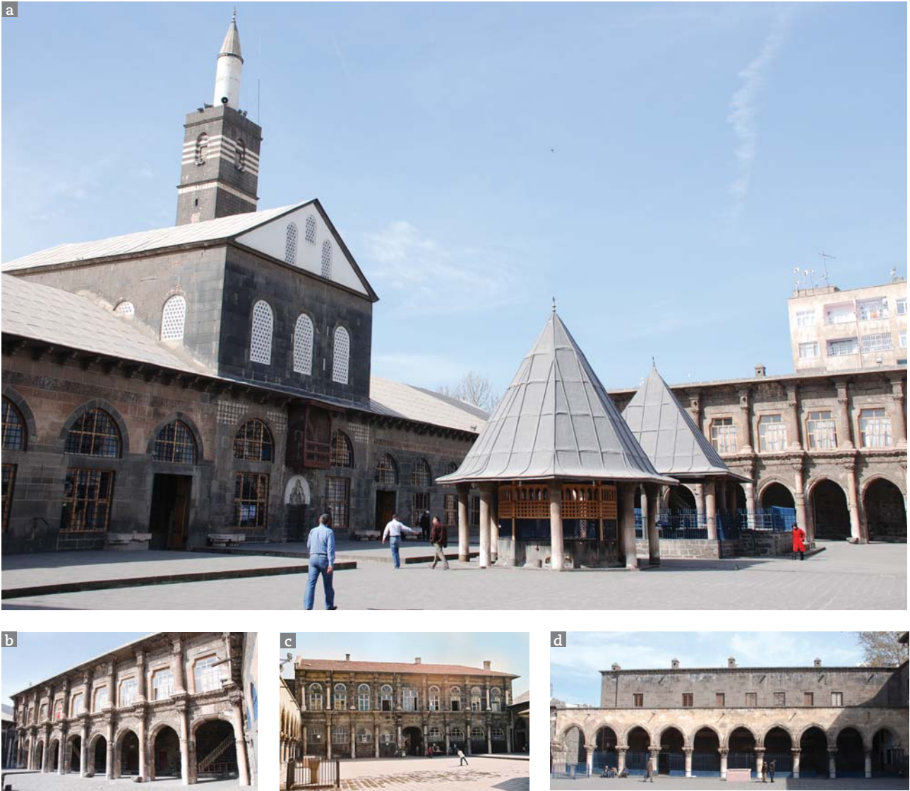
Şekil 4. Ulu Cami'nin sütunlarını gösteren fotoğraflar: (a) Güney cephesi, (b) Batı cephesi, (c) Doğu cephesi, (d) Kuzey cephesi (Fotograf: Neslihan Dalkılıç)
