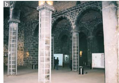
Şekil 8. Suriçi'ni çevreleyen duvarların üzerinde yer alan iki burcun sütunlarını gösteren fotoğraflar: (a) Yedi Kardeş burcu, (b) Keçi burcu. Sütunlar yekpare olup metal halkalar, kırılmayı önlemek için kullanılmıştır. (Fotoğraf: Neslihan Dalkılıç)
