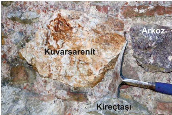
Şekil 6. Damatrix Sarayı'nın duvarlarında kullanılan arkoz (Kurtköy Formasyonu), kuvarsarenit (Aydos Formasyonu) ve kireçtaşları (Dolayoba ve Kartal Formasyonları)
