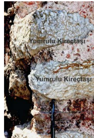
Şekil 7. Damatrix Sarayı'nın duvarlarında kullanılan yumrulu kireçtaşı (İstinye Formasyonu)
