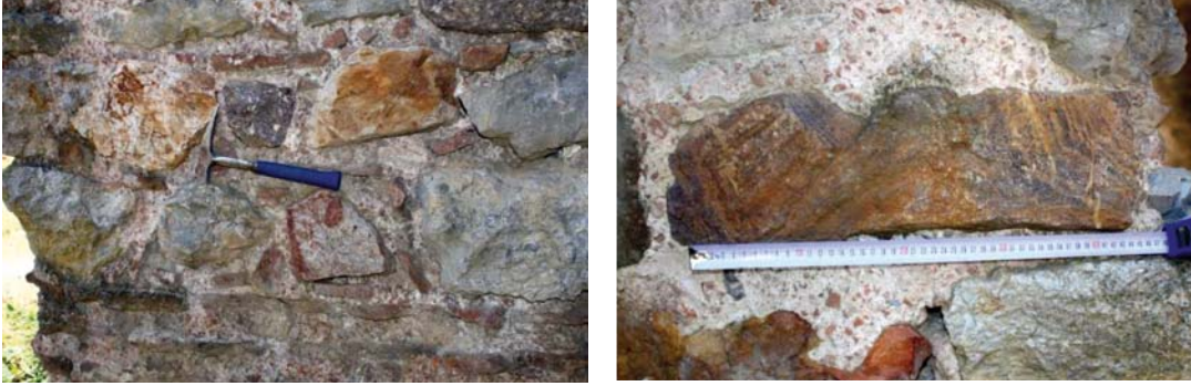
Şekil 14. Tuğla - harç uygulamaları. Solda kabaca biçimlendirilmiş taş bloklar arasında ufak taş parçaları ile sağlamlaştırılmış harç malzemesi, sağda ise tuğla parçacıkları ile dayanımı artırılmış derz malzemesi
