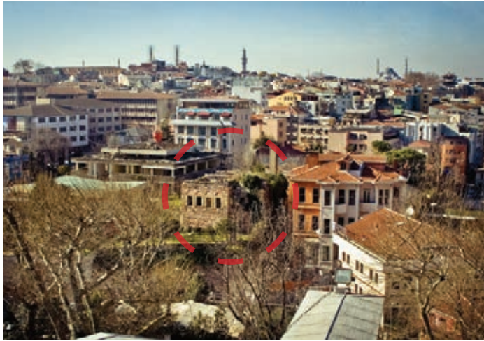
Şekil 5. Taş Oda'nın güncel durumu Fotoğraf: F. Kocaisık (2010)
