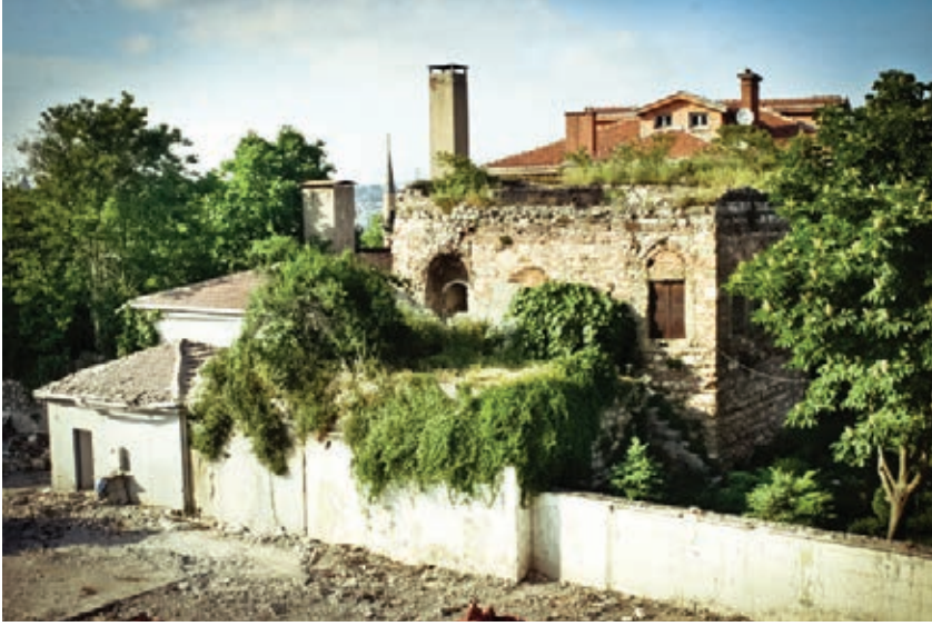
Şekil 11. Yapının güneybatı cephesi ve kuzeybatı yönünde yer alan bitişik durumdaki yapılar
