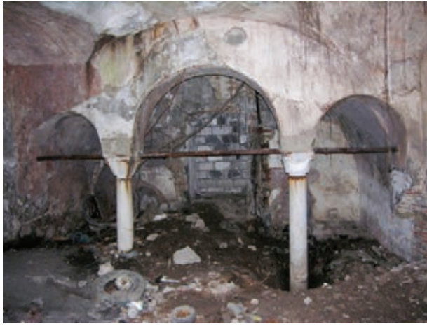
Şekil 13. Yapının zemin kat Z 02 kuzeybatı duvarında iki yanı nişli ve zemin kat girişi olup olmadığı araştırılması gereken alan ve iki mermer sütun ile oluşturulmuş üçlü açıklık
