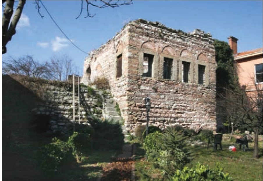
Şekil 2. Yapının güneydoğu cephesi
