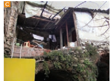
Şekil 11. Zeyrek Camii, hünkâr kasrının altyapısını oluşturan tonozlar, A. doğudan birinci tonoz içinde civit kalıntısı (2003), B. Aynı tonoz (2012), C. Batıdan birinci tonoz ve üzerindeki uygunsuz ekler (2012)
