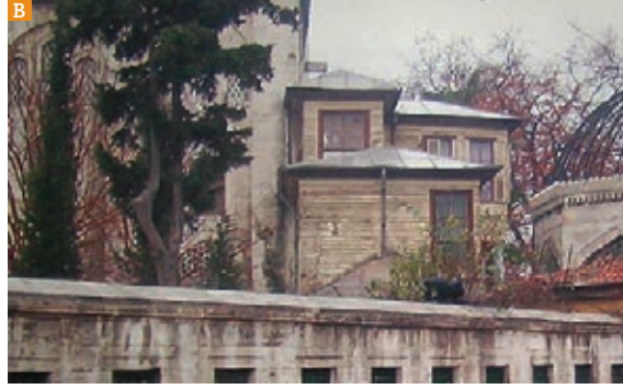
Şekil 5. A. Eyüp Sultan, B. Üsküdar Atik Valide hünkâr kasırları (2003)
