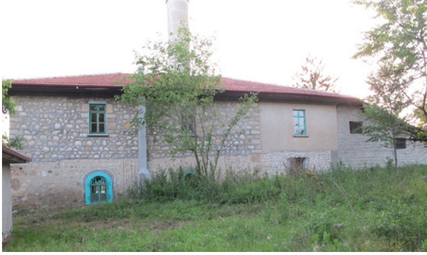
Foto. 2- Doğu Cephe, Genel Görünüm
