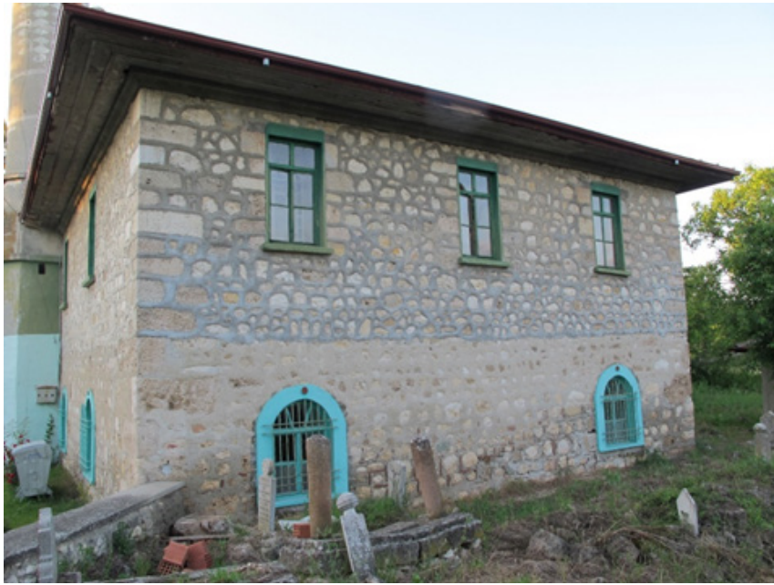
Foto. 4- Aşağı Ayvalı Köyü Camisi, Güney Cephe, Genel Görünüm
