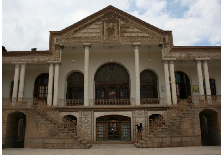
Foto. 22: Zemin Kata Çıkan Merdivenler
