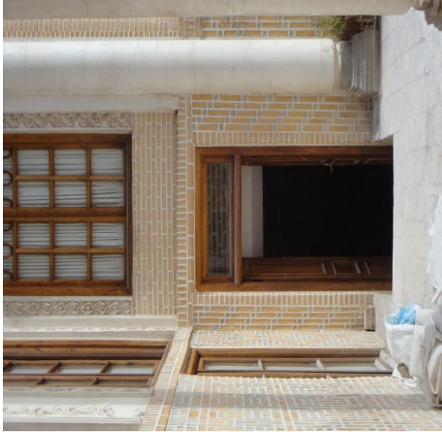
Foto. 5: Bodrum Kat Giriş
