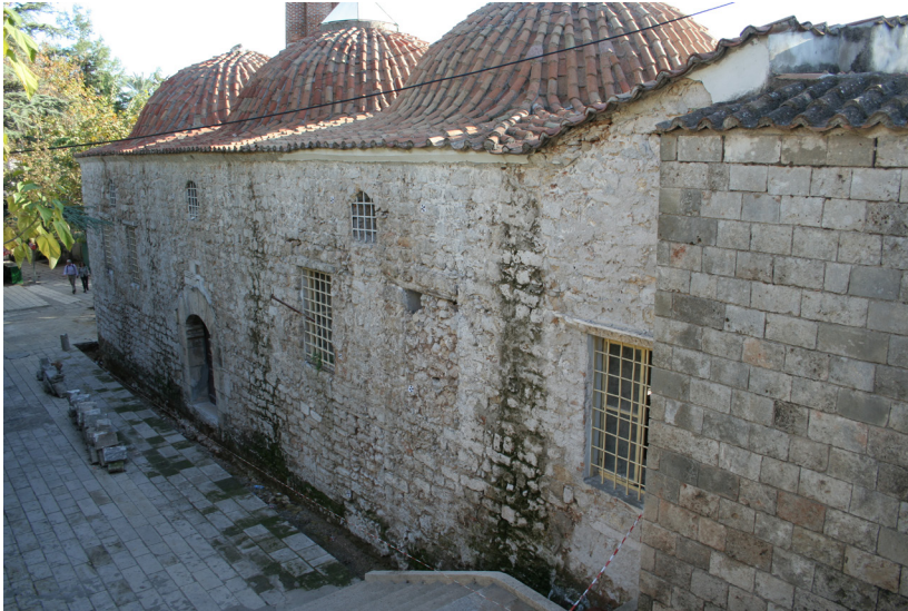
Şekil 02: Yivli minare Camisinin batı tarafında bulunan sur duvarı
