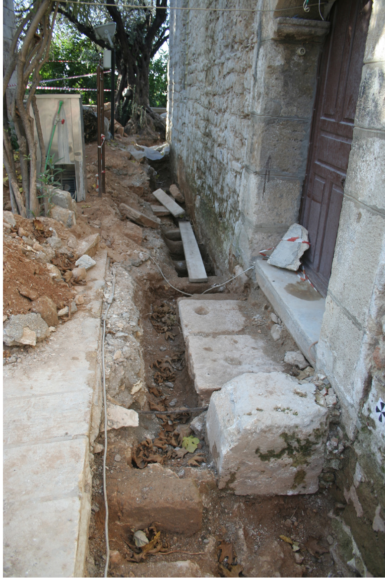
Şekil 07 : Caminin doğu cephesindeki drenaj kazısı
