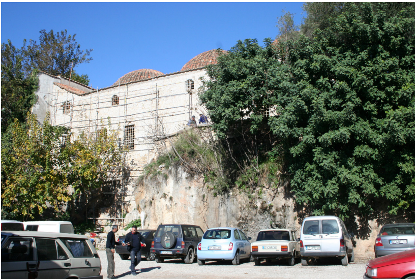
Şekil 03: Caminin güney cephesi.
