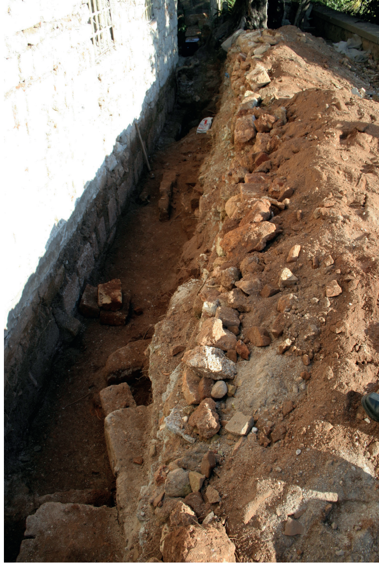
Şekil 04 : Caminin güney cephesindeki drenaj kanalı kazısı
