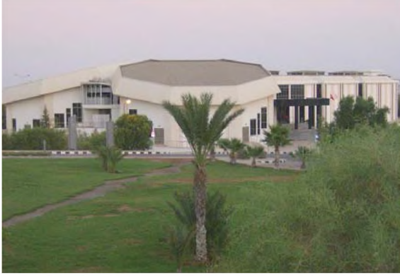
(Fotoğraf 1): Yakın Doğu Üniversitesi Büyük Kütüphane Binası
