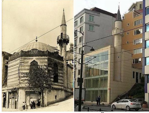
Şekil 2. Süheyl Bey Cami Restorasyon Öncesi ve Sonrası
