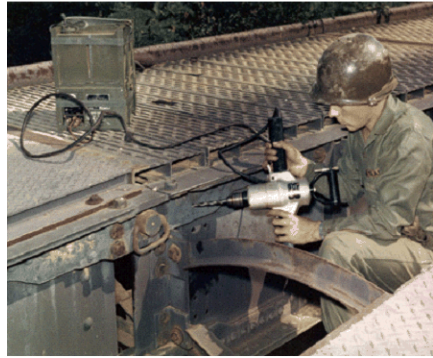
Şekil 3. Bir Amerikan Ordu askerinin yakıt hücresiyle çalışan seyyar matkapla çalışması, 1965.
