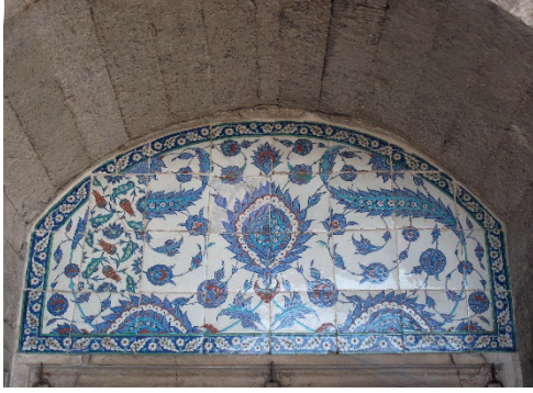
Resim 10. Rüstem Paşa Camii Çini Kapı Alınlığı
