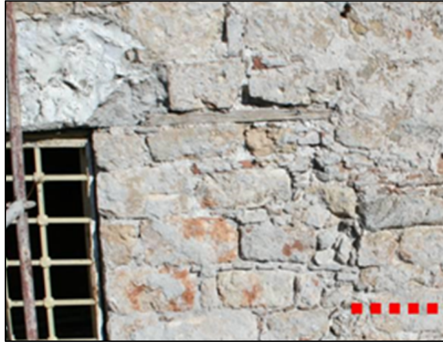
Resim 11. Yivli Minare Camiinde Çatlak ve Yarıklar (Yazar Arşivinden).
