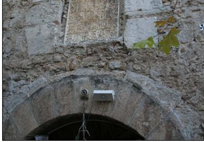
Resim 7. Yivli Minare Camiinde Taş Malzeme Kullanımı (Yazar Arşivinden).
