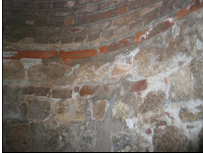
Resim 14. Yivli Minare İç Bölümlerindeki Nem ve Tuz Çıkışları (Yazar Arşivinden).
