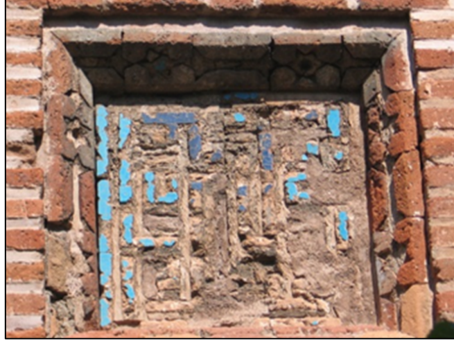
Resim 13. Yivli Minare Tuğla Bölümlerindeki Parça Kayıpları (Yazar Arşivinden) .
