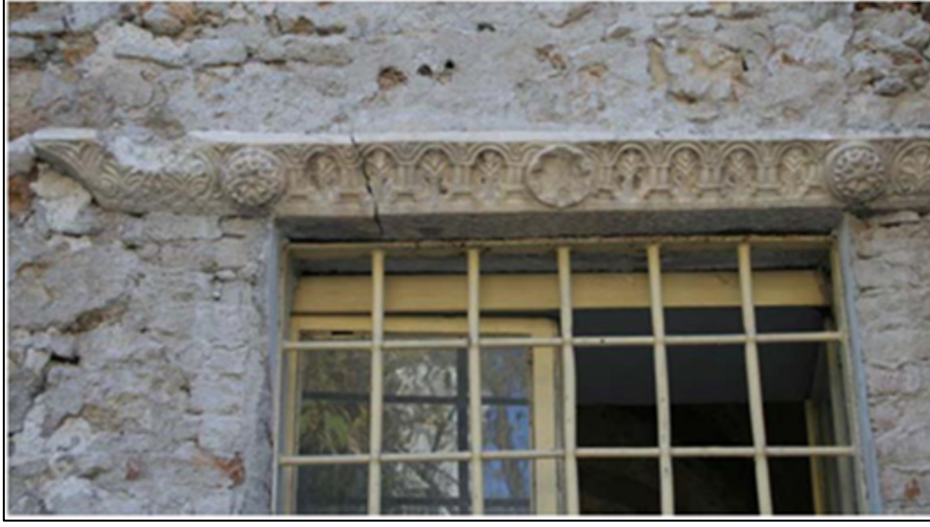
Resim 10. Dış Cephede Pencere Lentosu Olarak Kullanılan Bizans Dönemi devşirme malzemeleri (Yazar Arşivinden).
