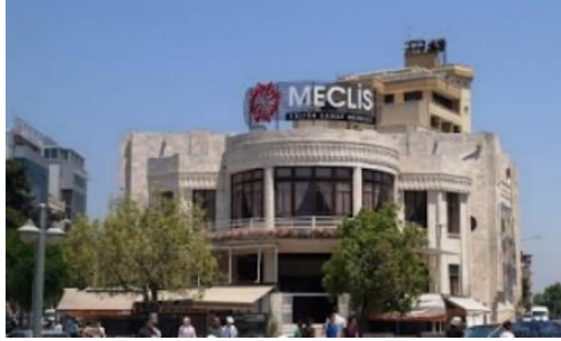
Binanın dış Görünümü
