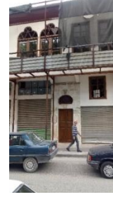
Binanın dış görünümü
