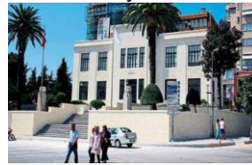
Binanın Dış Görünümü
