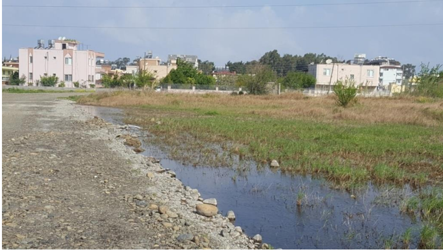
Fotoğraf 3. 3 No'lu Bozuk drenaj sahasının bulunduğu alanda araç ve yaya geçişi amacıyla yapılan yol ve yüzeyi kaplayan suyun görünümü.
