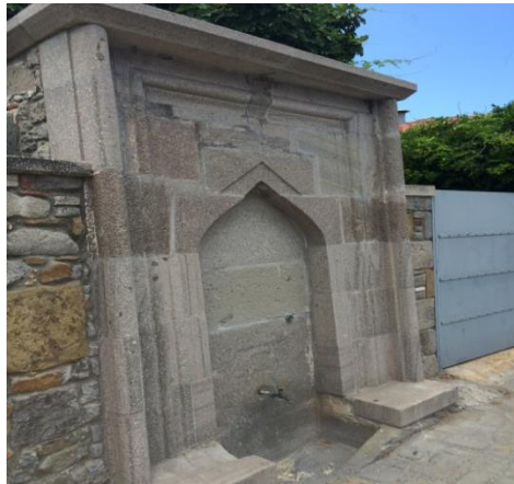
Resim 2.1 (Kasaba merkezindeki kitâbesi sökülmüş Türk çeşmelerinden biri) [Haziran 2018]
