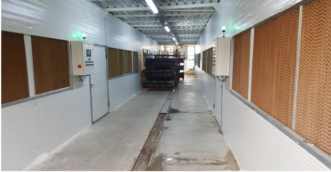
Şekil 4. Mantar Üretim Tesisinde Depo-Hangar Bölümü
