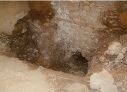
Şek. 18: Oda-2'nin de kuzey duvarında bulunan ocak (Kaynak: Ceray Mimarlık ve Restorasyon).
