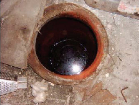
Şek. 6: Beykoz, Yalıköy, 456 Ada, 11 Parsel'de yer alan Mediha Yaran Evi mutfağında zemine gömülü su küpü (Kaynak: Erdine, 2008, 144).
