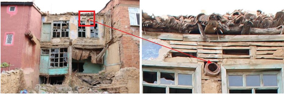
Şek. 17: Oda-3'te bulunan baca deliğinin kuzey cepheden görünüşü. 2018.
