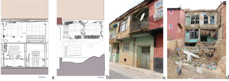
Şek. 12: 19 kapı numaralı evin güney (a) ve kuzey (b) cephesi röhlövesi ve güney (c) ve kuzey (d) cephe fotoğrafları, 2018 (Kaynak: çizim (a-b): Ceray Mimarlık ve Restorasyon).
