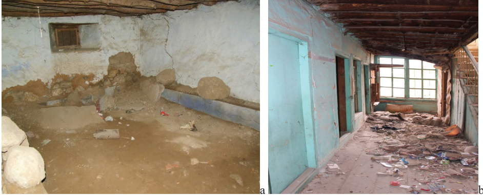
Şek. 20. Ambar olarak kullanıldığı düşünülen oda-1'in görünüşü, toprak zemin ve mazgal pencere uygulaması gözlenmektedir ve yapı içinde testi kalıntıları (Kaynak: a- Ceray Mimarlık ve Restorasyon, b- Yazarlara ait fotoğraf arşivi, 2018).
