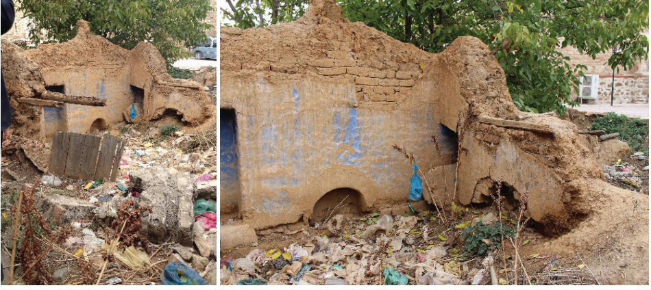
Şek. 19: Avludaki bulunan yıkıntı haldeki müştemilat ve ocak kalıntıları, 2018.
