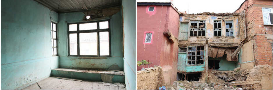
Şek. 21: Oda-4'te açılır kanatlı pencere örneği ve önündeki ahşap seki (a) ve kuzey cephedeki tahtaboş izleri, 2018.
