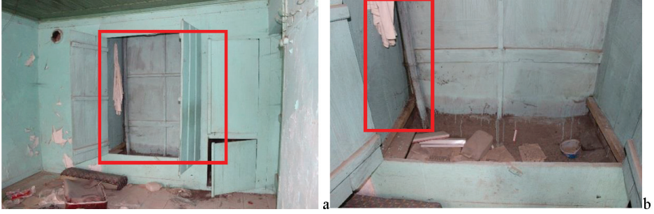
Şek. 23: Oda-6'da bulunan gusülhane (a) ve gusülhane içindeki su tahliye borusu (b) kırmızı kutu içinde gösterilmiştir, 2018.
