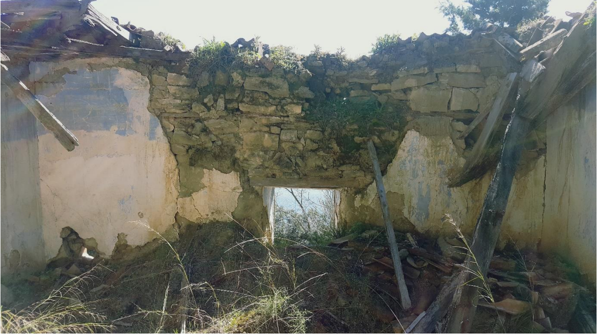
Türbe yapısının iç güney duvarı
