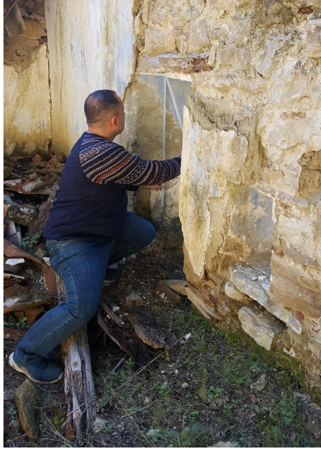
Türbe yapısının iç batı duvarında pencere ölçümü
