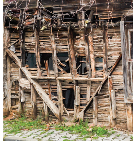
Şekil 22. İstanbul'daki ahşap konutlarda yapı sistemini (Soldaki örnek Sarıyer'de, sağdaki ise Heybelida'dadır)
