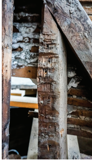
Şekil 23. Arnavutköy'de bir ahşap evin taşıyıcı sisteminde görülen el aleti izleri, 2015
