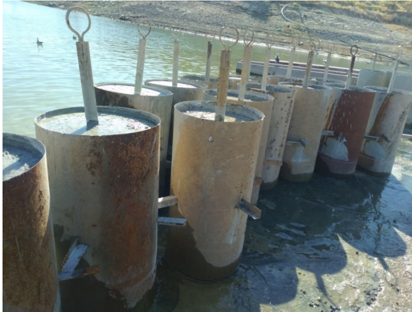
Foto 4: Yüzer platformu dengelemek için kullanılan beton bloklar
