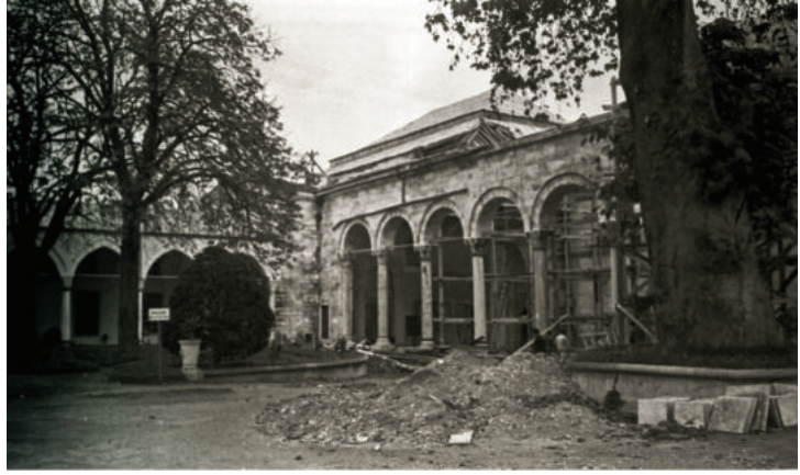
Topkapı Sarayı Restorasyonu 1935 - 1945: Fatih Köşkü Revakları (İAE, s. 115).
