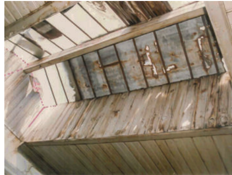
Şekil 27. Ana yapıdan iç mekân fotoğrafı (III. no.lu KVKBK aşısı)
