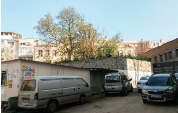
Şekil 29. Şapel arka cephe (güneybatı) fotoğrafı (Doğan, 2015)
