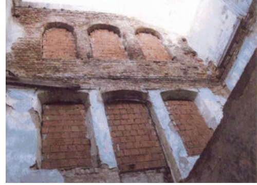
Fotoğraf 13. Yeni tuğla ile kapatılan ön cephe pencereleri
