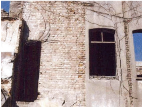
Fotoğraf 8. Arka cephe 1. kattaki kapı boşluğu
