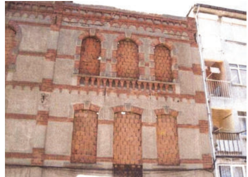
Fotoğraf 10. Ana bina ön cephe-sağ yan
