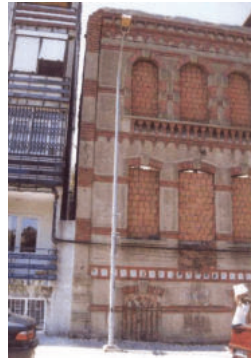
Fotoğraf 9. Ana bina ön cephe-sol yan
