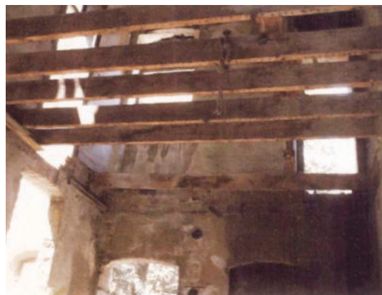
Fotoğraf 21. Ahşap döşeme kirişleri(Z07)
