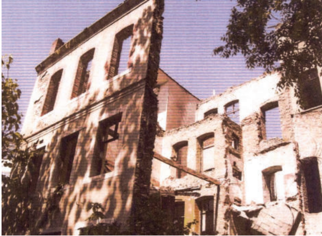
Fotoğraf 3. Küçük bina giriş (bahçe) cephesi
