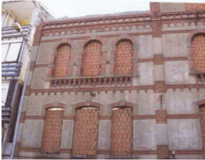
Fotoğraf 17. Ana bina ön cephe-pencere ve tuğla hatıllar
