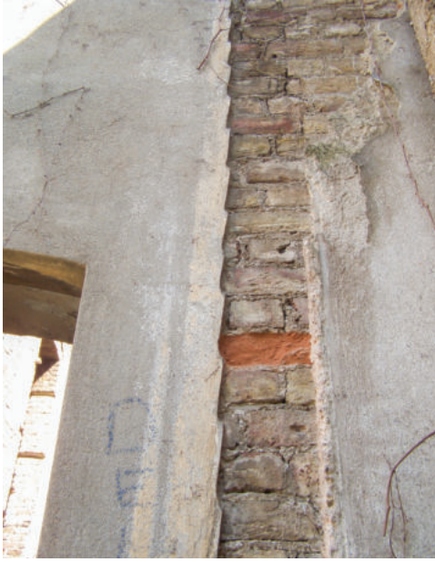
Sekil 17. Ana yapının arka cephesinde (güneybatı) tespit edilen ahşap yapı izleri (Doğan, 2008)
