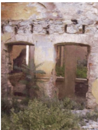
Fotoğraf 20. Yıkılan basık kemerli kapı (Z01)
