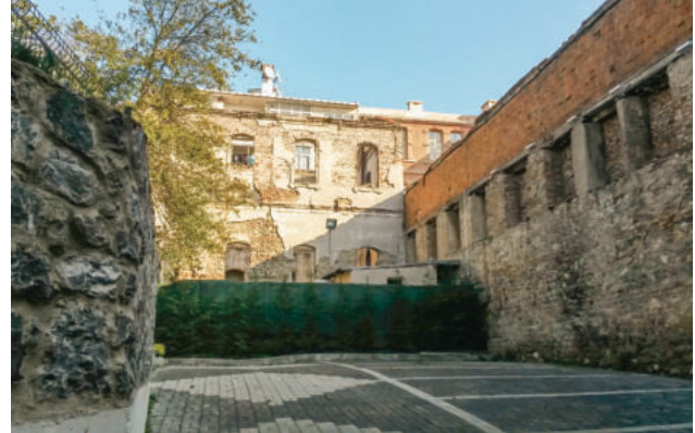
Şekil 30. Şapel arka cephe (güneybatı) fotoğrafı (Doğan, 2015)
