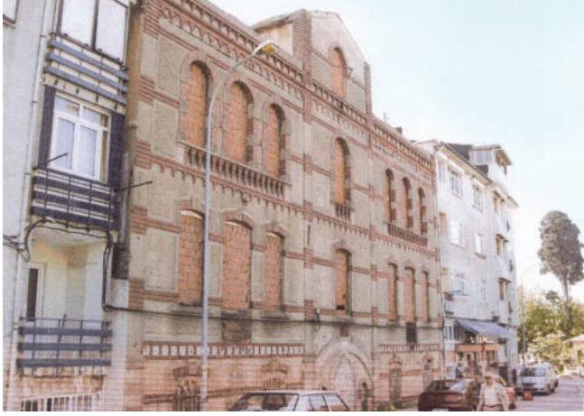
Fotoğraf 1. Ana bina ön (sokak) cephe
