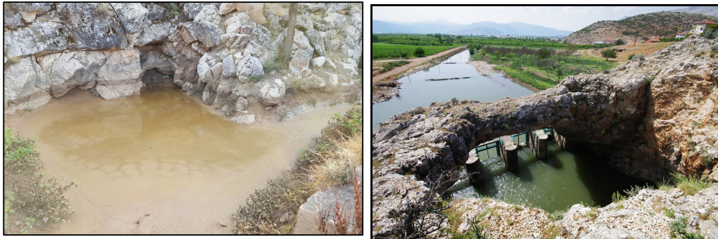
Şekil 9. Yağış sonucunda tıkanan Karaköy düdeninden bir görünüm (Sol). Karagöl düdeni (sağ) bazı dönemlerde yağışla gelen suları aynı hızla drene edememektedir.
