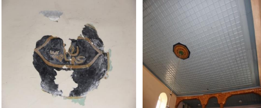
Şekil 5. Harim bölümü kalem işi örneği ve ahşap tavanı
