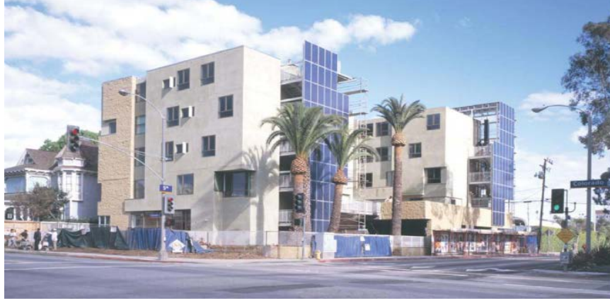
Şekil 17. Cephe tasarımını etkileyen mavi renkli PV paneller (Colorado Court Apartment Complex, Angela Brooks, California, 2002) (Stang & Hawthorne, 2005)
