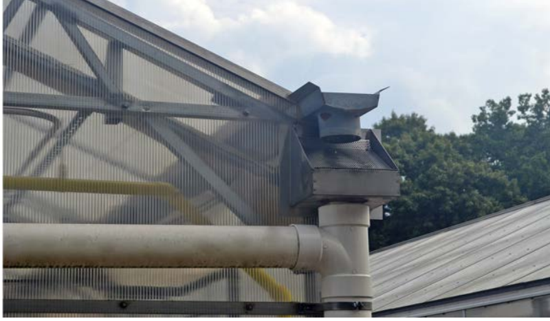
Şekil 16. Yağmur Suyu Toplama Sistemi (Novak vd., 2014)
