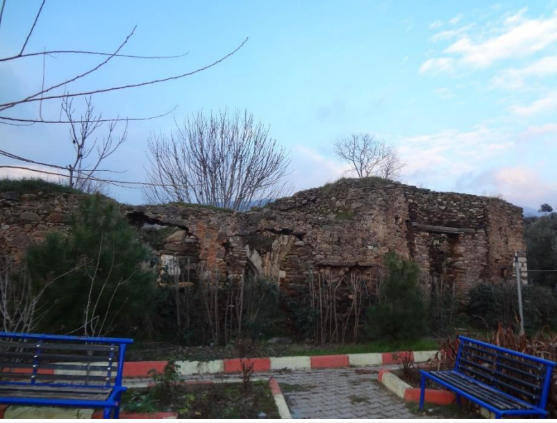
Res. 16- Suludere Köyü Hamamı, güney cephe.
