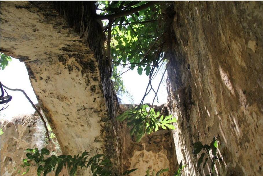
Res. 21- Suludere Köyü Hamamı, sıcaklık kuzey kemer.
