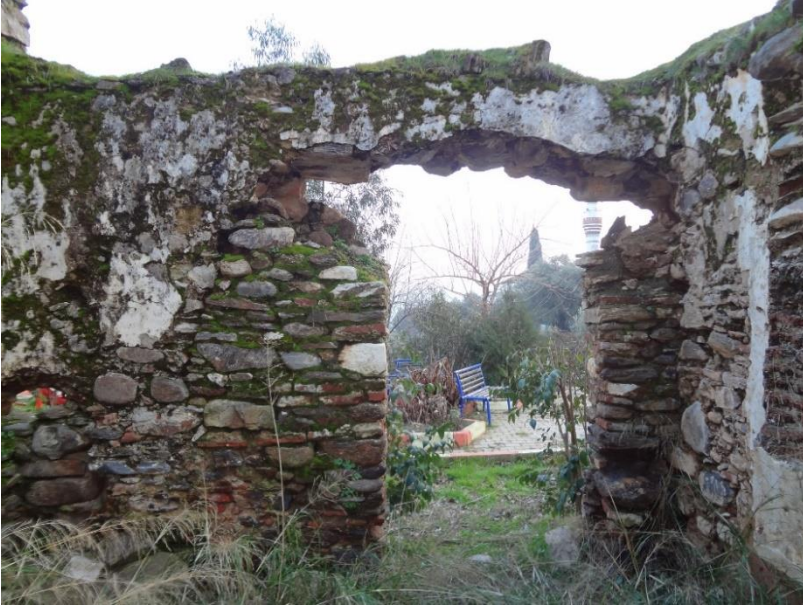
Res. 22- Suludere Köyü Hamamı, sıcaklık güney duvar.
