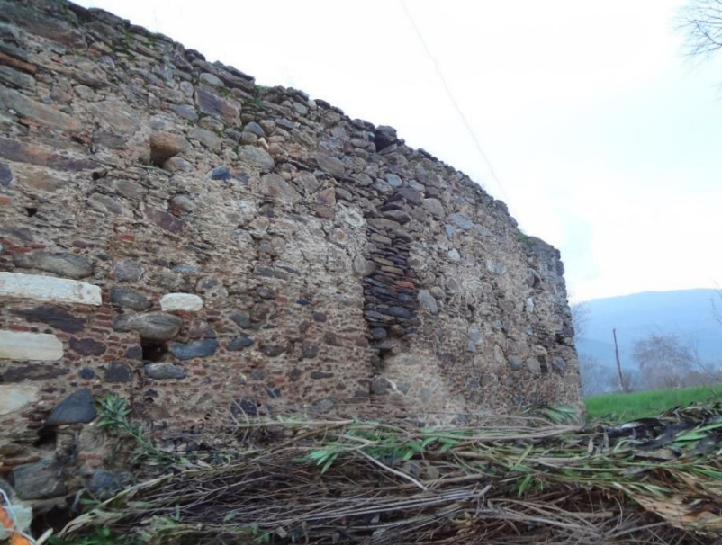
Res. 17- Suludere Köyü Hamamı, doğu cephe.
