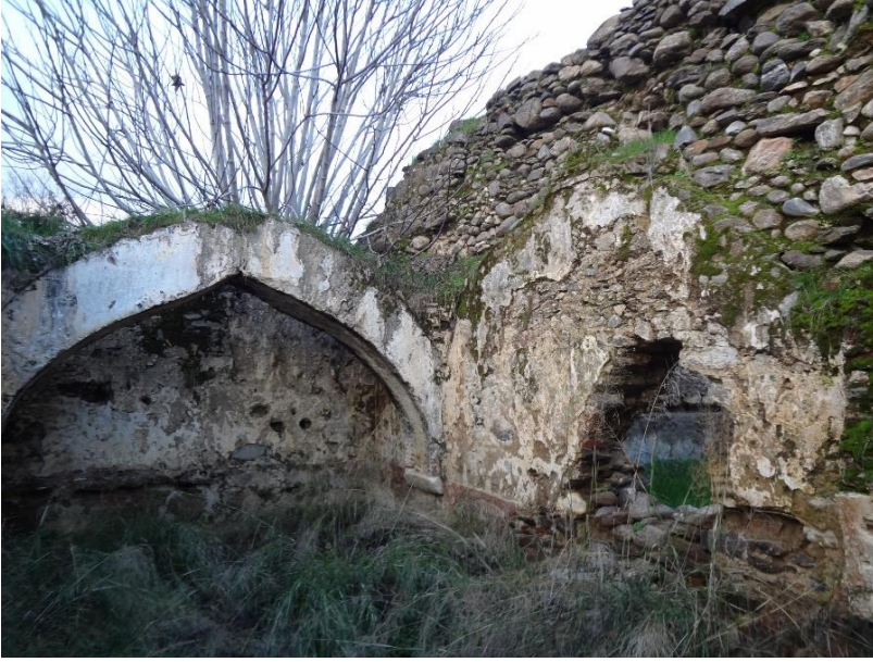
Res. 20- Suludere Köyü Hamamı, sıcaklık kuzeydoğu duvarı.
