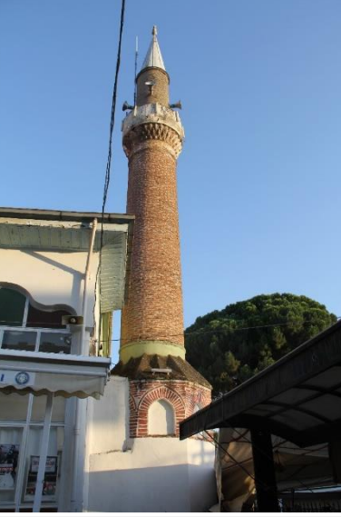
Resim 13- Kiraz İsa Bey Camii, minare.
