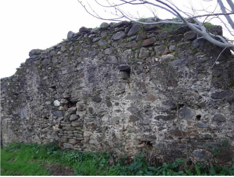
Res. 18- Suludere Köyü Hamamı, kuzey cephenin doğusu.
